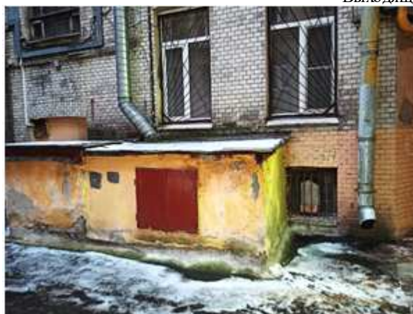
Фото 11. Оконный проем, во двор, отдельный вход со двора – заложен кирпичом, примыкает кирпичная пристройка
