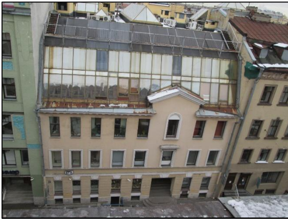
Фото 23. Вид из окна помещения
