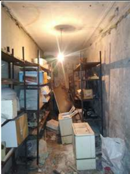
Фото №3: Внутреннее состояние пом. 11-Н
