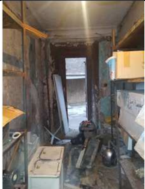
Фото №4: Внутреннее состояние пом. 11-Н
