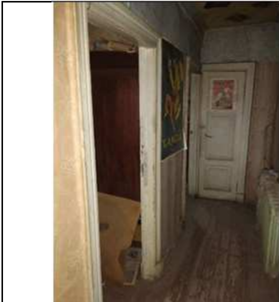
Фото № 19: Внутренний вид пом. 10-Н
