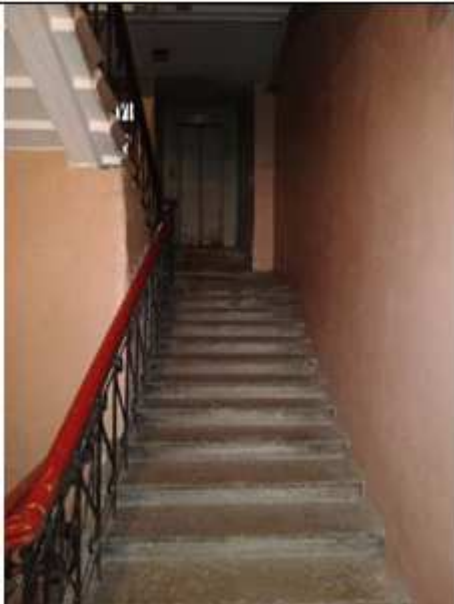
Фото №7: Лестница ведущая в пом. 10-Н
