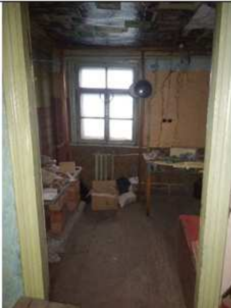
Фото №17: Внутренний вид пом. 10-Н
