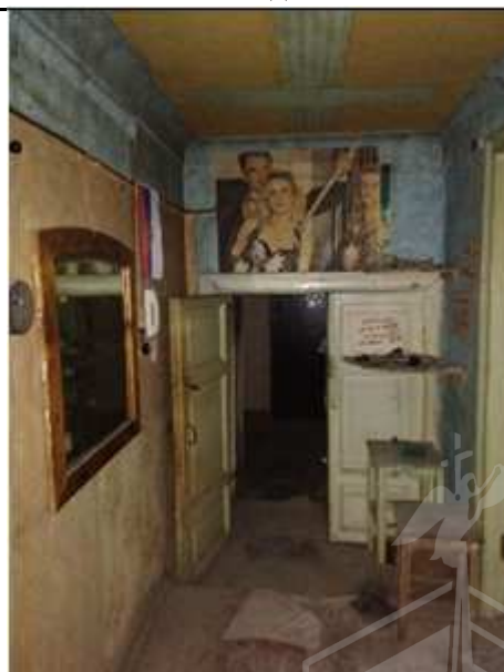
Фото №12: Внутренний вид пом. 10-Н
