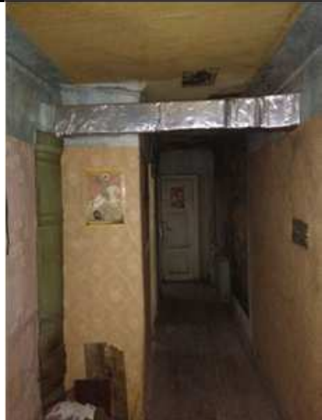
Фото №14: Внутренний вид пом. 10-Н
