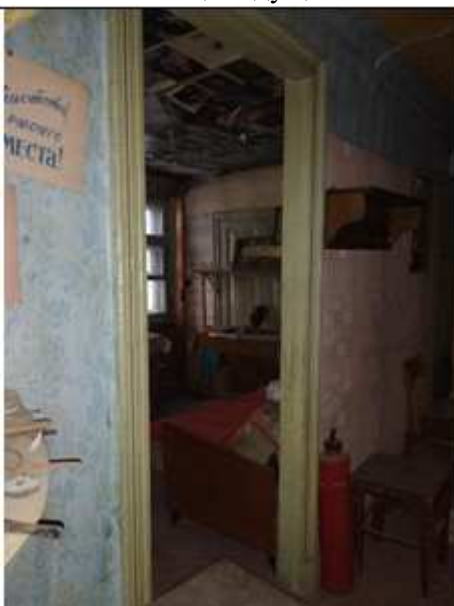
Фото №11: Внутренний вид пом. 10-Н
