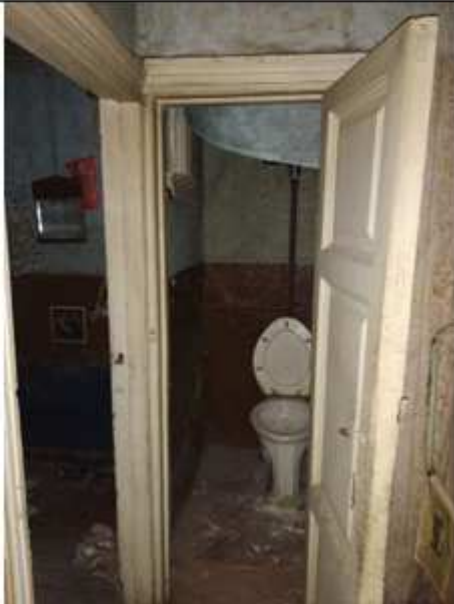
Фото №13: Внутренний вид пом. 10-Н
