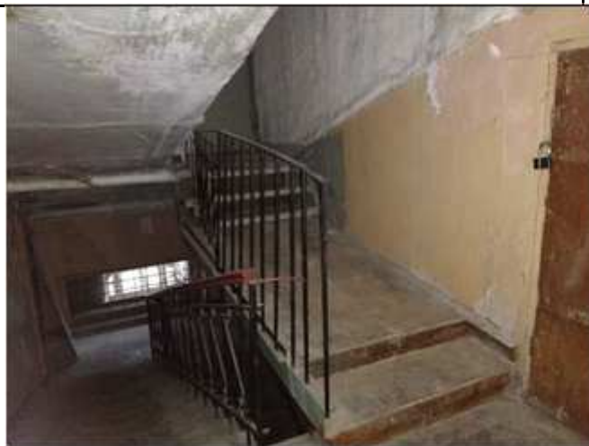
Фото №23 Лестница на чердак
