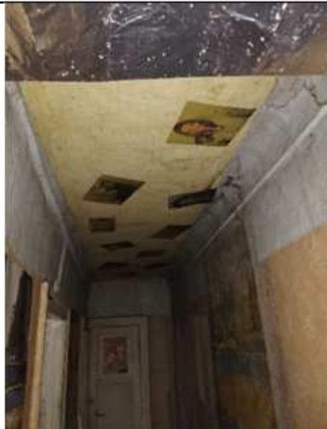
Фото № 20: Внутренний вид пом. 10-Н
