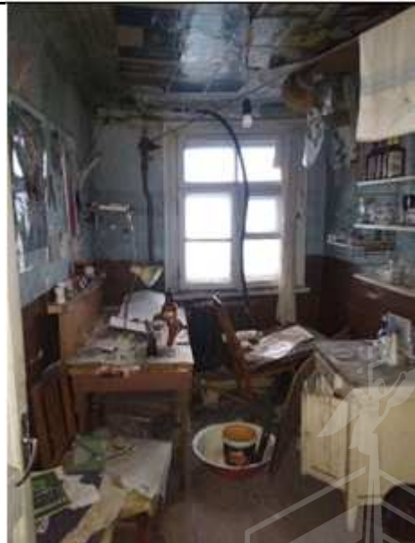
Фото №18: Внутренний вид пом. 10-Н
