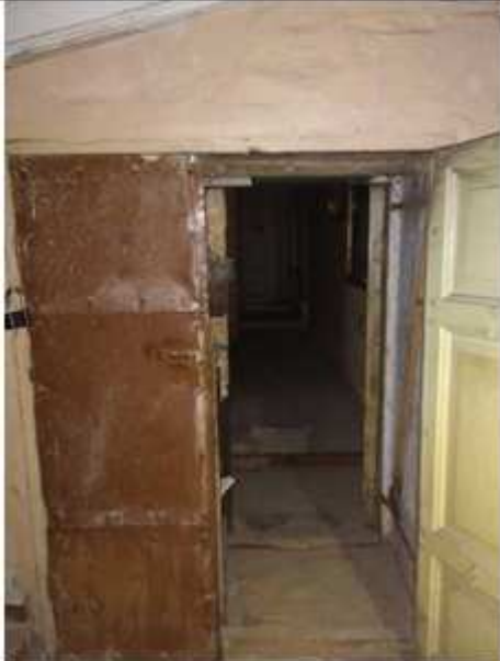
Фото № 21: Вход в пом. 10-Н
