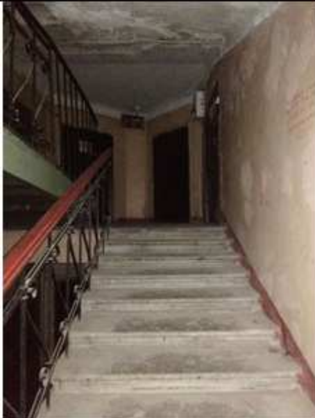
Фото №9: Лестница ведущая в пом. 10-Н
