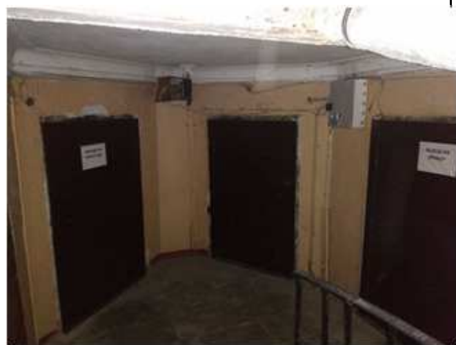
Фото №10: Вход в пом. 10-Н
