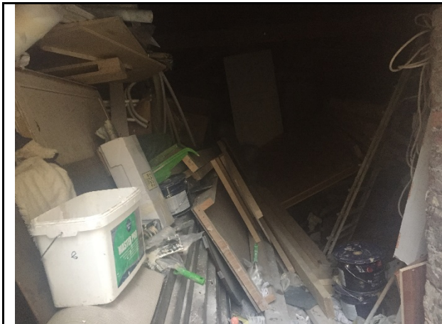
Фото 17. Типичное состояние Объекта оценки
