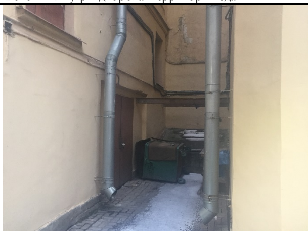
Фото 13. Внутри дворовая территория здания
