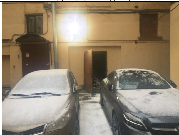
Фото 15. Вход в Объект оценки
