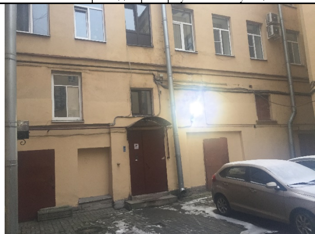
Фото 12. Внутри дворовая территория здания
