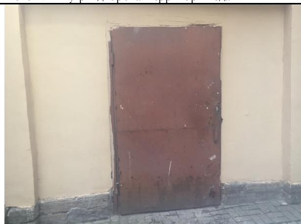
Фото 14. Вход в Объект оценки
