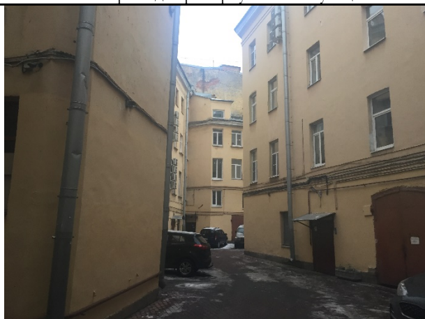
Фото 11. Внутри дворовая территория здания
