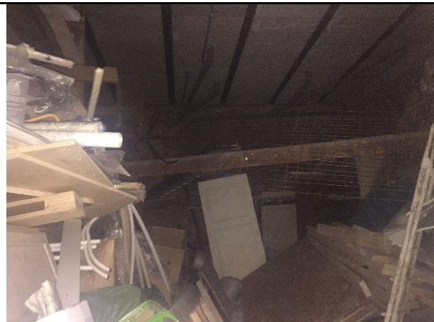
Фото 18. Типичное состояние Объекта оценки
