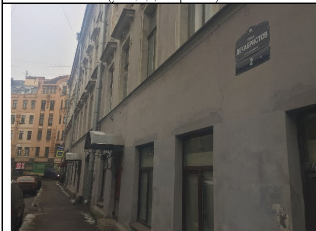
Фото 7. Вид здания расположения Объекта оценки (улица Декабристов)
