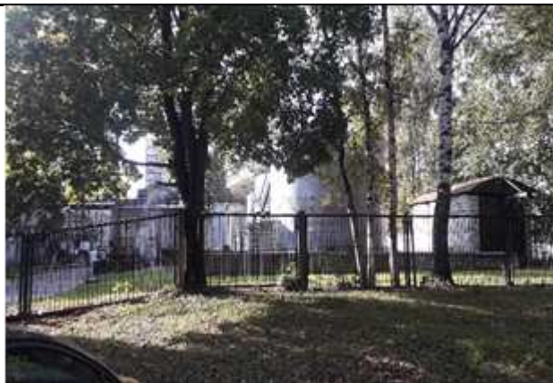
Фото №5 Внешнее окружение: Котельная «3-я Выборгская»
