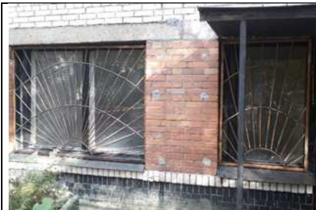
Фото №17 Вход в помещение №1
