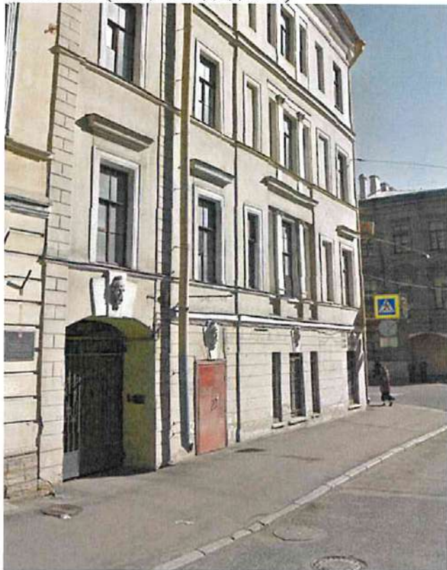
Фото № 9 (общий вид здания)
