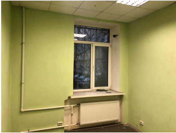
Фото 7 Общий вид и состояние помещений
