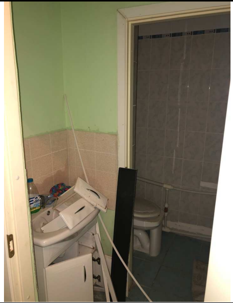
Фото 8 Общий вид и состояние помещений
