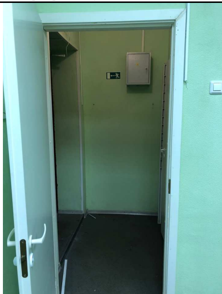
Фото 5. Вход в помещение
