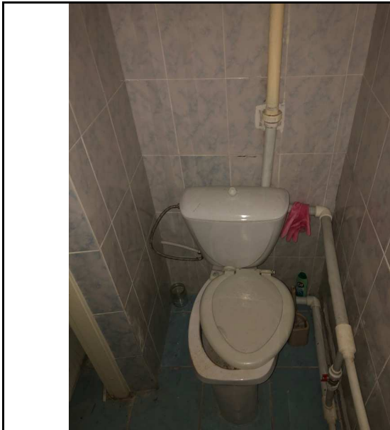
Фото 13 Общий вид и состояние помещения
