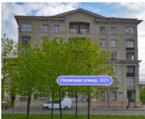
Фото 1 Фасад здания (данные ЯндексКарт)
