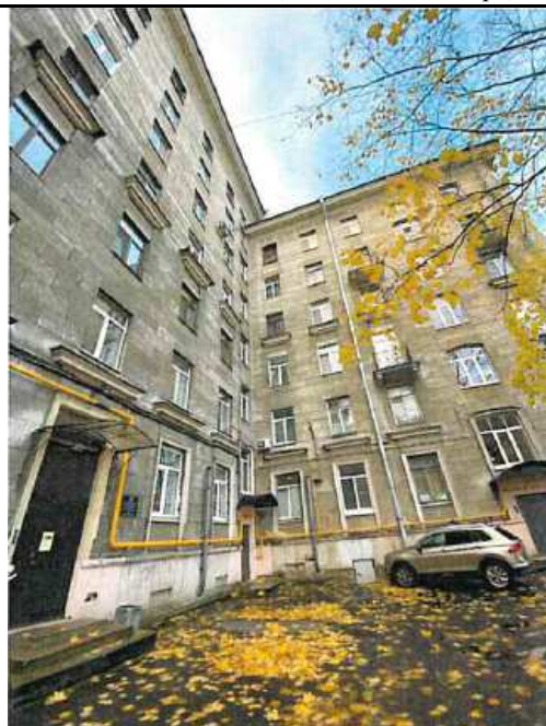
Фото 4 Фасад здания, внутридомовая территория
