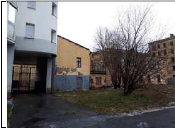
Фото 14. Вид Объекта оценки, примыкающего к соседнему зданию
