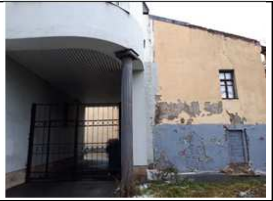
Фото 15. Вид Объекта оценки, примыкающего к соседнему зданию
