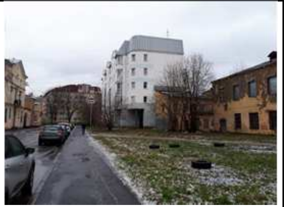
Фото 17. Вид Объекта оценки, примыкающего к соседнему зданию
