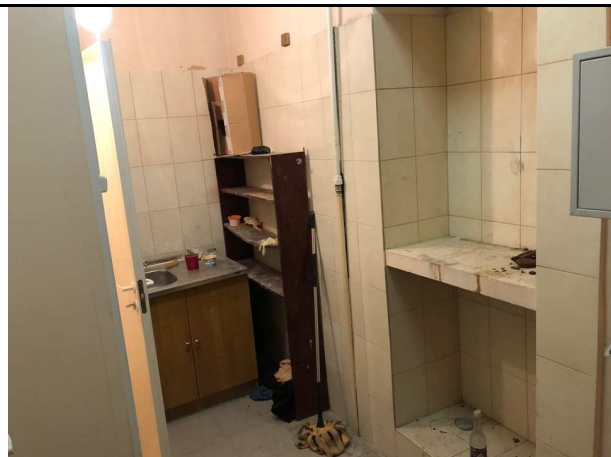
Фото 28 Общий вид и состояние помещения
