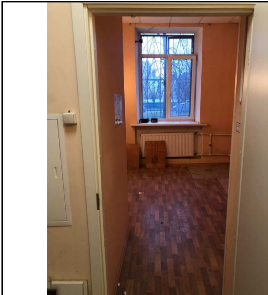
Фото 19 Общий вид и состояние помещения
