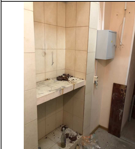
Фото 17 Общий вид и состояние помещений
