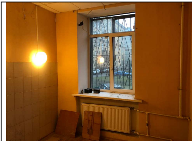
Фото 25 Общий вид и состояние помещения
