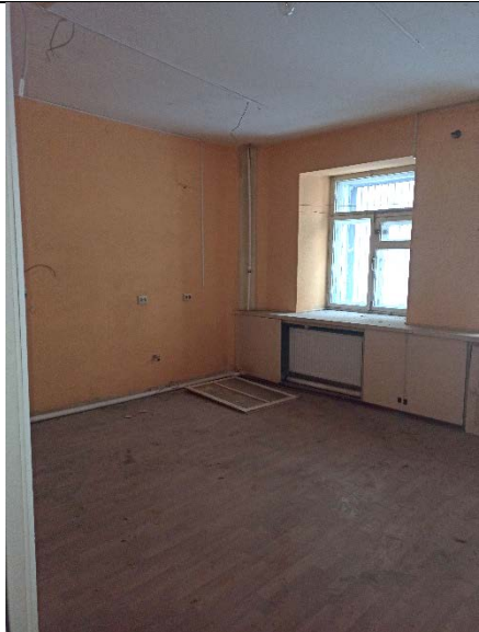
Фото №8 Внутреннее состояние Объекта
