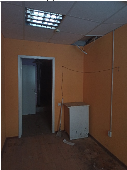
Фото № 17: Внутреннее состояние Объекта
