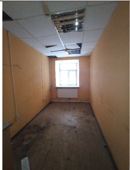
Фото № 16: Внутреннее состояние Объекта
