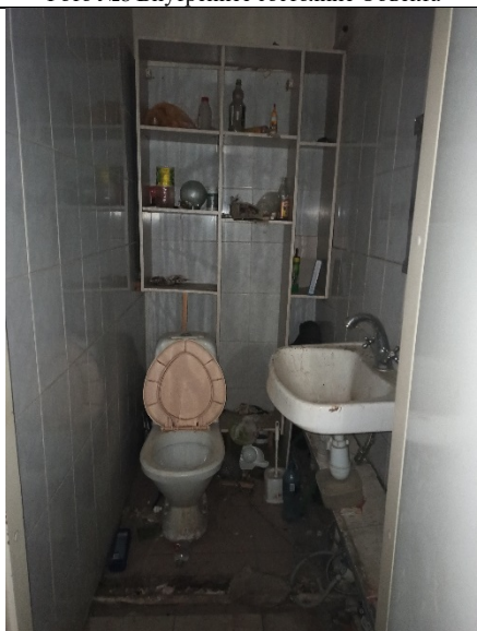
Фото №10: Внутреннее состояние Объекта
