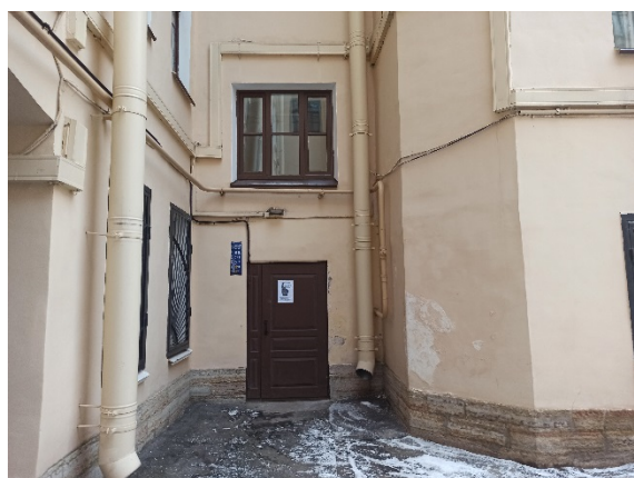
Фото №3: Общий вход в пом. 1-Н
