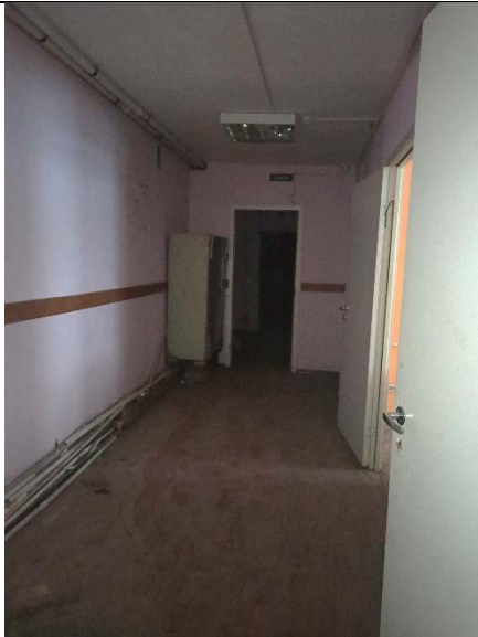
Фото №7: Внутреннее состояние Объекта
