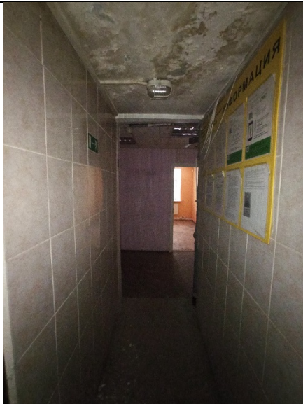
Фото № 15: Внутреннее состояние Объекта
