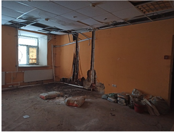
Фото № 19: Внутреннее состояние Объекта
