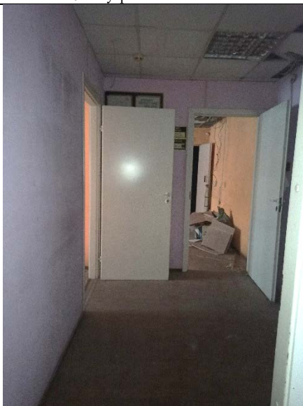
Фото № 11: Внутреннее состояние Объекта
