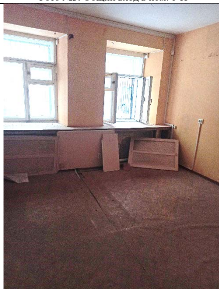
Фото №5: Внутреннее состояние Объекта
