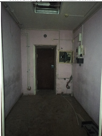
Фото №9: Внутреннее состояние Объекта
