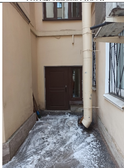
Фото №4: Общий вход в пом. 4-Н
