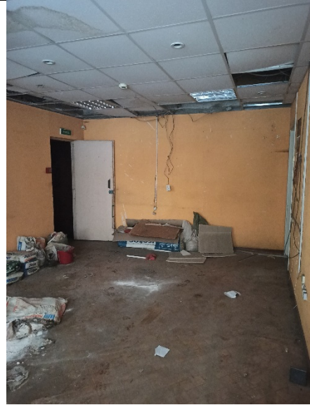
Фото №20: Внутреннее состояние Объекта
