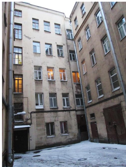
Фото 2. Вид здания, в котором расположен Объект оценки, со двора
