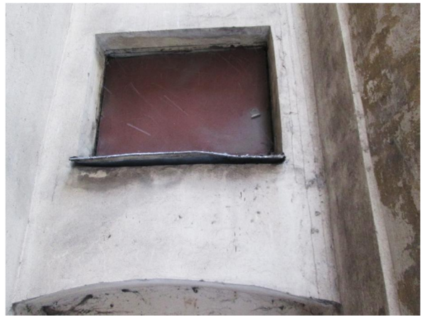
Фото 12. Оконный проем 2 помещения 3-Н
