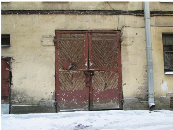
Фото 9. Отдельный вход в помещение 1-Н со двора
