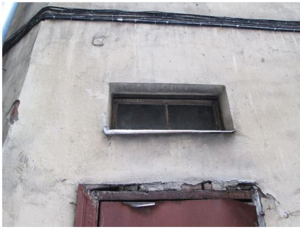
Фото 11. Оконный проем 1 помещения 3-Н
