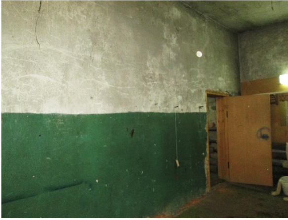
Фото 17. Дверной проем между ч.п. 1 пом. 1-Н и ч.п. 1 пом. 3-Н
