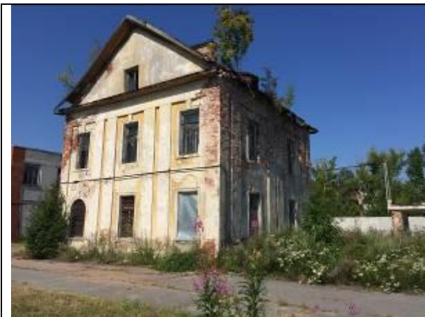
Фото 3. Вид на здание размещения Объекта оценки.
