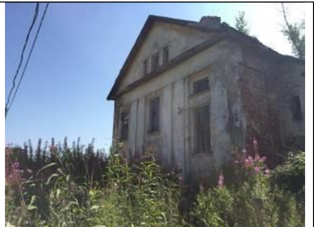
Фото 4. Вид на здание размещения Объекта оценки.
