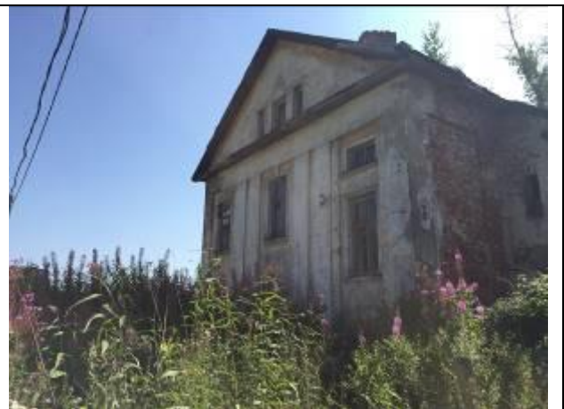
Фото 4. Вид на здание размещения Объекта оценки.
