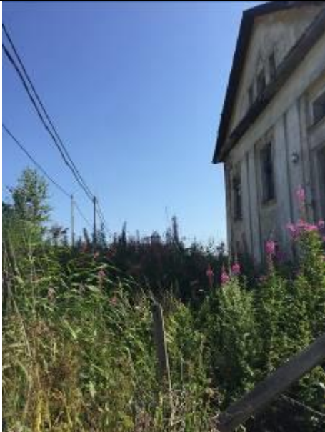
Фото 9. Ближайшее окружение, вид на здание размещения Объекта оценки.
