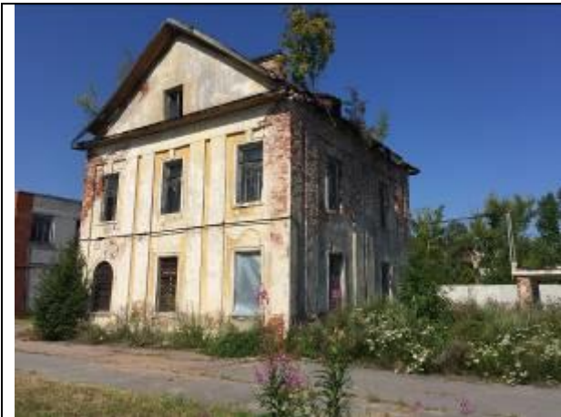
Фото 3. Вид на здание размещения Объекта оценки.
