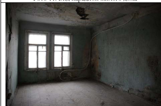
Фото 13. Типичной состояние Объекта оценки
