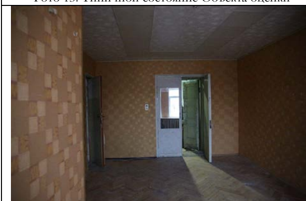
Фото 15. Типичной состояние Объекта оценки
