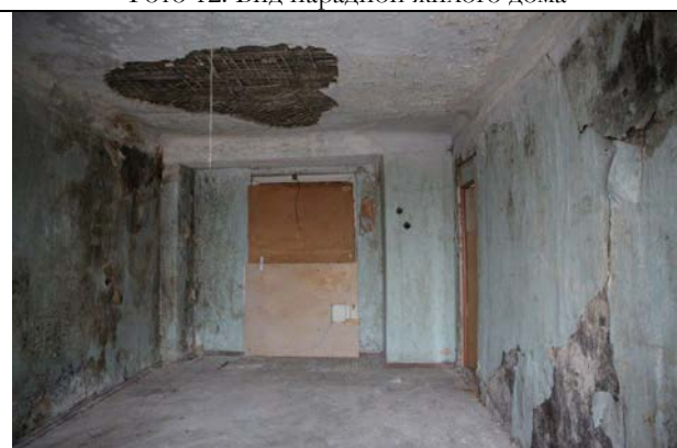
Фото 14. Типичной состояние Объекта оценки
