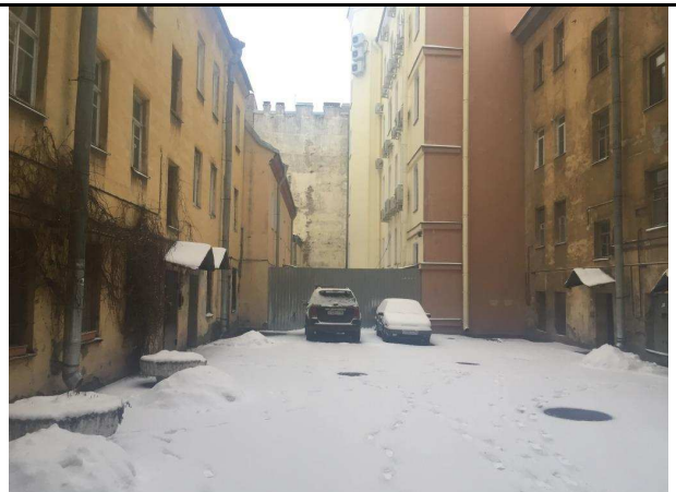
Фото 14. Вид внутри дворовой территории здания
