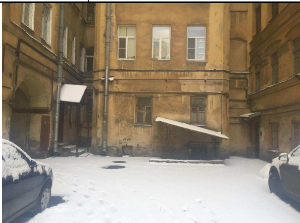
Фото 13. Вид внутри дворовой территории здания
