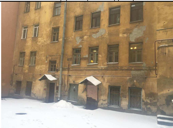
Фото 15. Вид внутри дворовой территории здания
