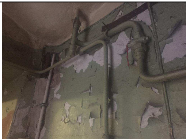
Фото 16. Типичное состояние Объекта оценки
