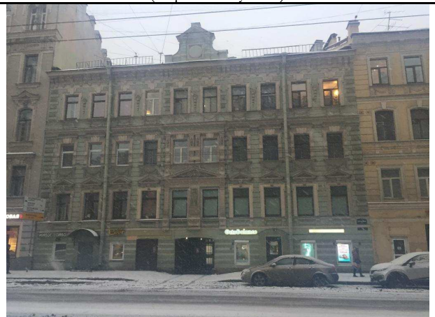
Фото 8. Вид здания расположения Объекта оценки
