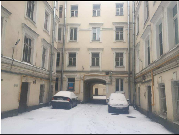
Фото 11. Вид дворовой территории здания расположения Объекта оценки
