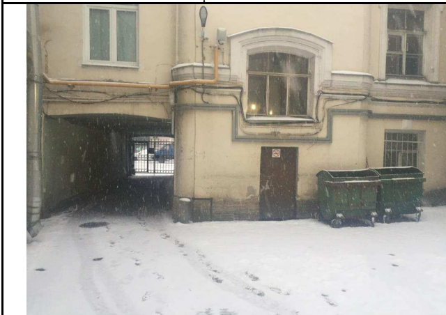
Фото 9. Проход через арку к дворовой территории здания расположения Объекта оценки
