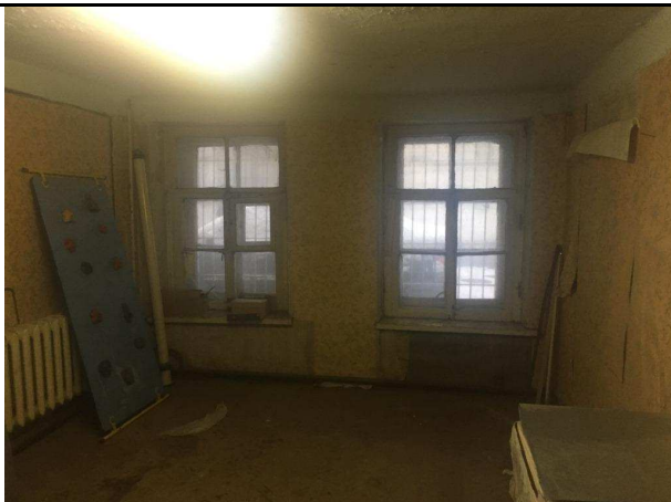
Фото 17. Типичное состояние Объекта оценки
