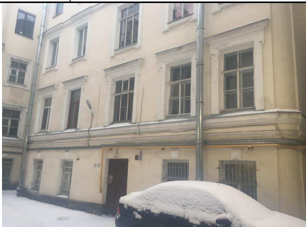
Фото 13. Вид дворовой территории здания расположения Объекта оценки
