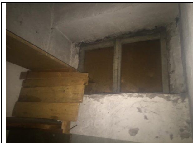
Фото 17. Типичное состояние Объекта оценки
