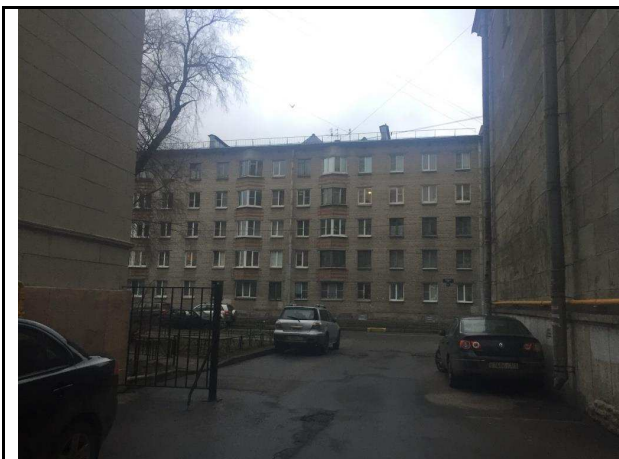
Фото 9. Внутри дворовая территория Объекта оценки
