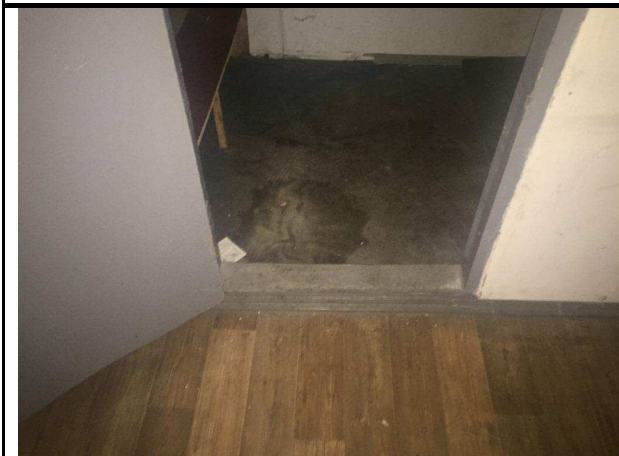
Фото 23. Типичное состояние Объекта оценки
