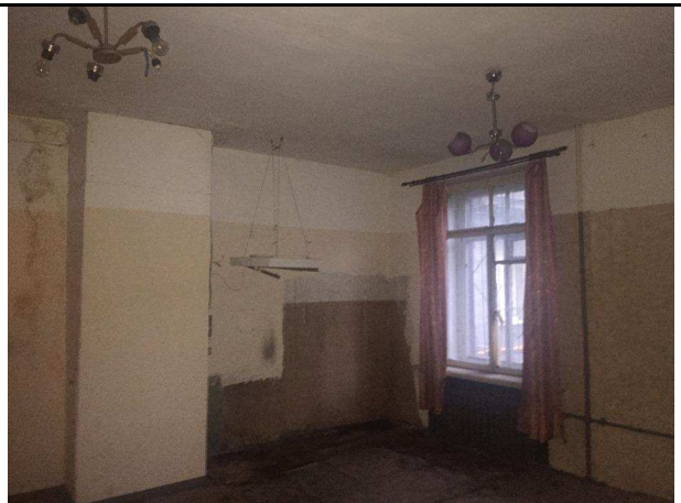
Фото 20. Типичное состояние Объекта оценки
