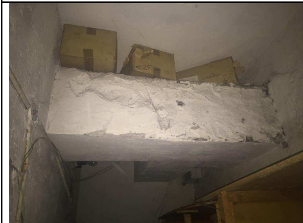
Фото 19. Типичное состояние Объекта оценки
