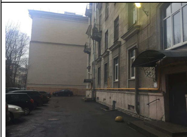
Фото 11. Внутри дворовая территория Объекта оценки
