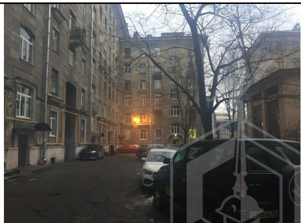
Фото 8. Внутри дворовая территория Объекта оценки
