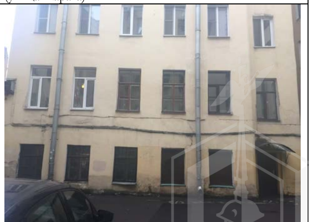
Фото 8. Вид здания расположения Объекта оценки
