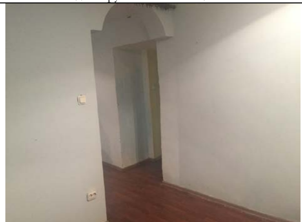
Фото 20. Типичное состояние Объекта оценки
