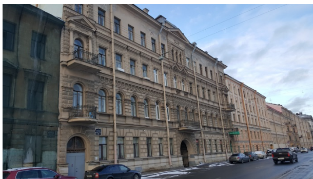
Фото 7. Вид здания расположения Объекта оценки (вид с фасада)
