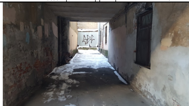
Фото 12. Вид внутреннего двора здания расположения Объекта оценки
