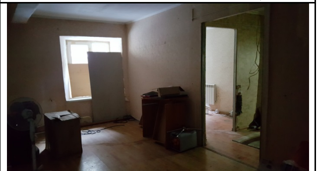
Фото 20. Типичное состояние Объекта оценки
