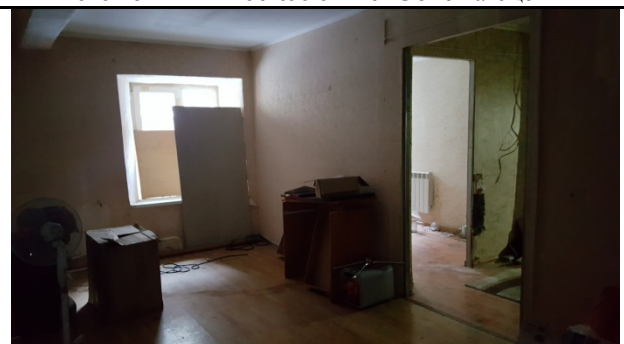
Фото 20. Типичное состояние Объекта оценки
