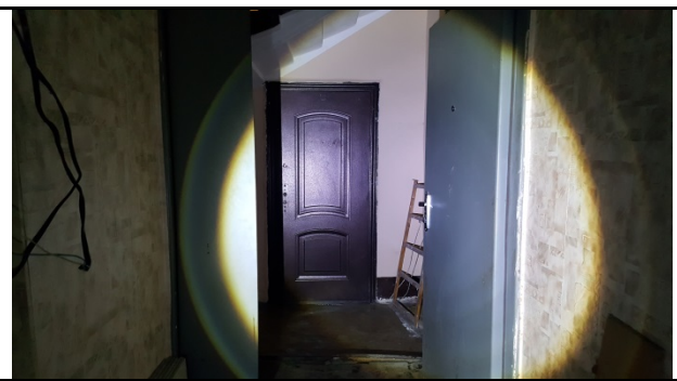
Фото 16. Вид входной группы Объекта оценки
