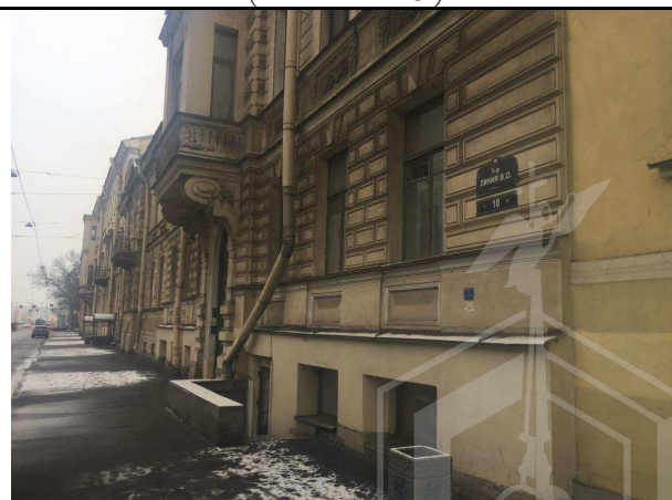
Фото 8. Вид здания расположения Объекта оценки
