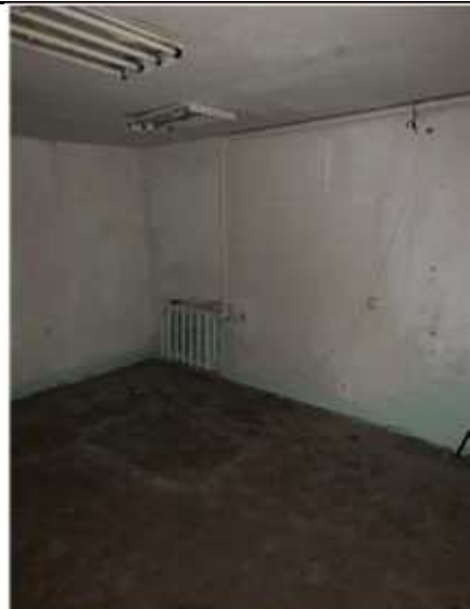
Фото № 16. Внутреннее состояние (№ 9)
