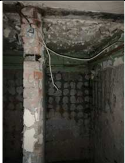
Фото № 20. Внутреннее состояние (№ 12)
