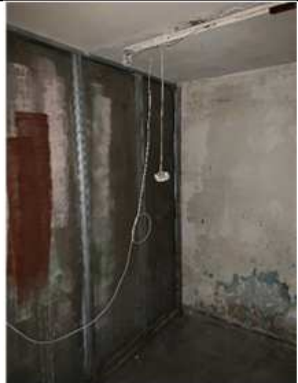
Фото № 10. Внутреннее состояние (№ 3)
