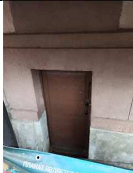
Фото № 26. Вход со двора
