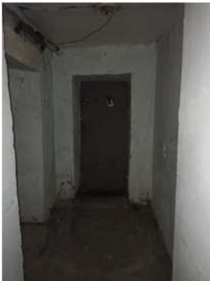
Фото № 13. Внутреннее состояние (№ 6)
