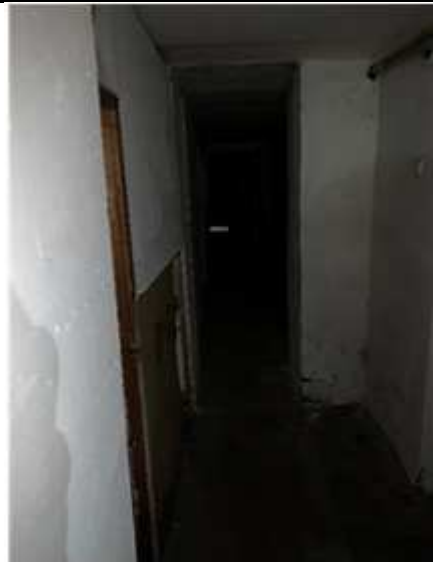
Фото № 14. Внутреннее состояние (№ 7)
