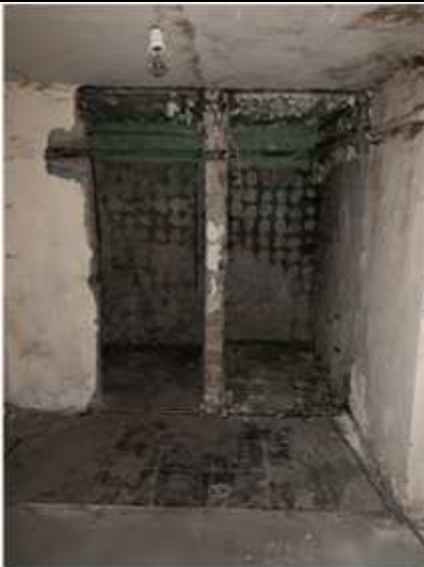
Фото № 19. Внутреннее состояние (№ 12)
