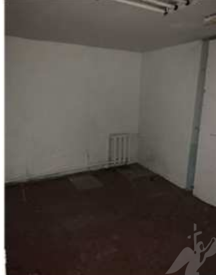
Фото № 18. Внутреннее состояние (№ 11)
