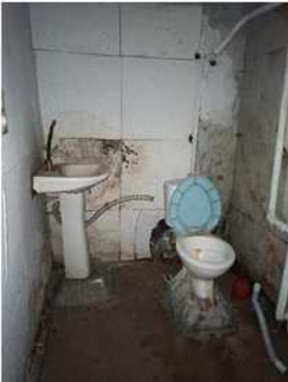
Фото № 17. Внутреннее состояние (№ 10)
