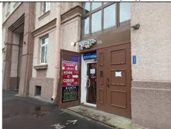
Фото № 4. Вход через соседнее помещение
