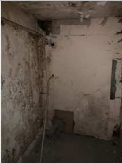
Фото № 21. Внутреннее состояние (№ 13)
