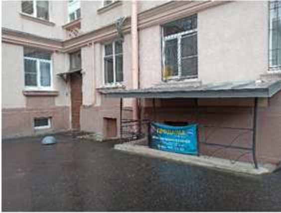
Фото № 25. Вход со двора
