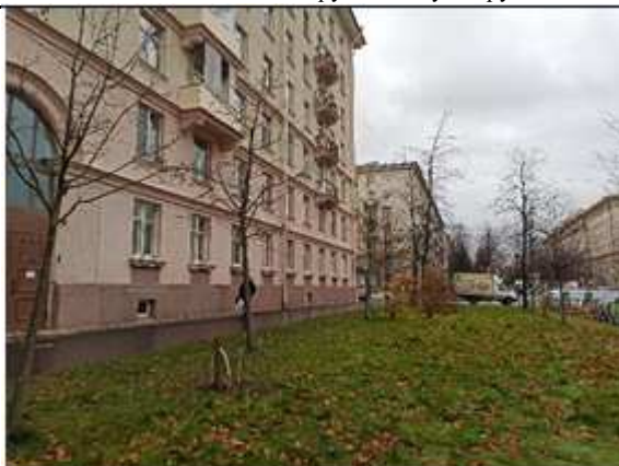
Фото № 3. Внешнее окружение с ул. Фрунзе
