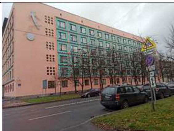
Фото № 2. Внешнее окружение с ул. Фрунзе
