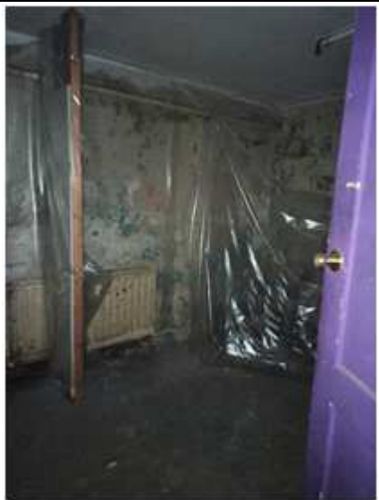
Фото № 9. Внутреннее состояние (№ 2)
