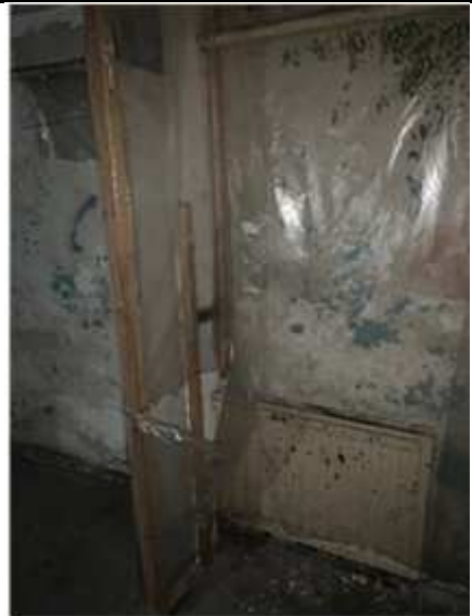
Фото № 8. Внутреннее состояние (№ 2)
