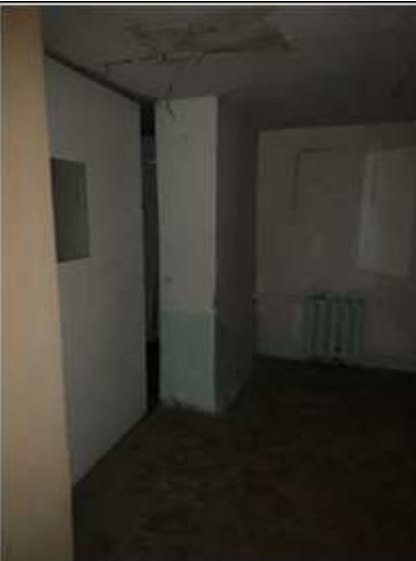
Фото № 15. Внутреннее состояние (№ 8)
