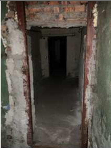
Фото № 7. Внутреннее состояние
