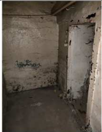
Фото № 22. Внутреннее состояние (№ 14)
