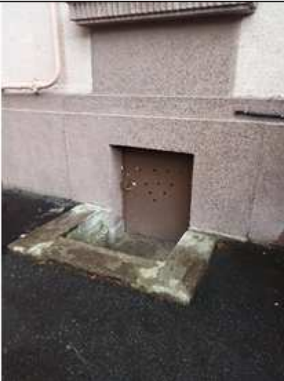
Фото № 27. Вход, через который осуществлялся осмотр объекта
