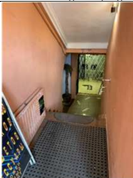
Фото № 5. Вход через соседнее помещение
