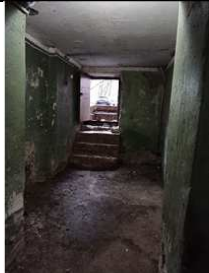
Фото № 28. Вход, через который осуществлялся осмотр объекта
