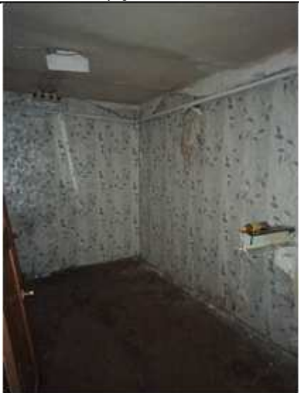
Фото № 11. Внутреннее состояние (№ 4)
