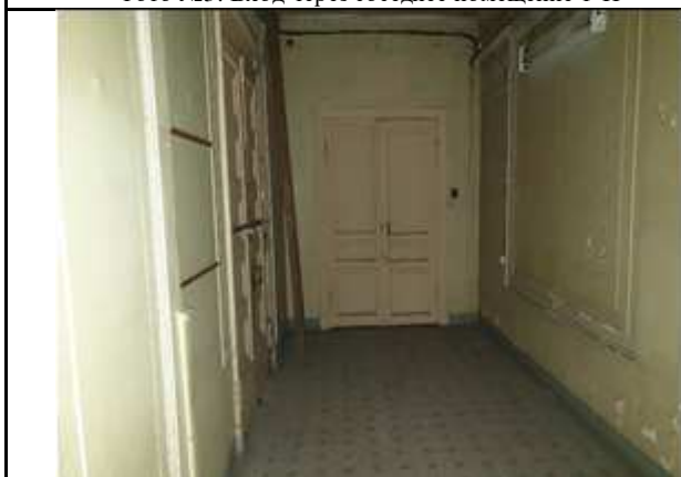
Фото №5: Внутреннее состояние Объекта
