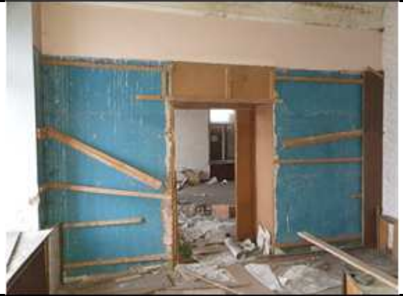
Фото № 18: Внутреннее состояние Объекта
