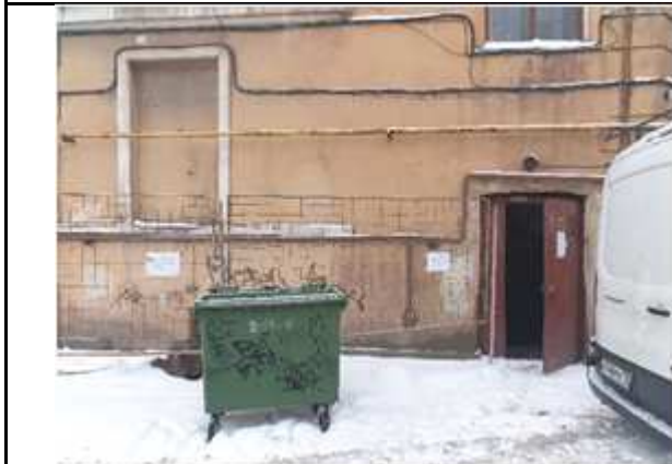
Фото №3: Вход через соседнее помещение 1-Н
