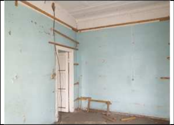
Фото №10: Внутреннее состояние Объекта
