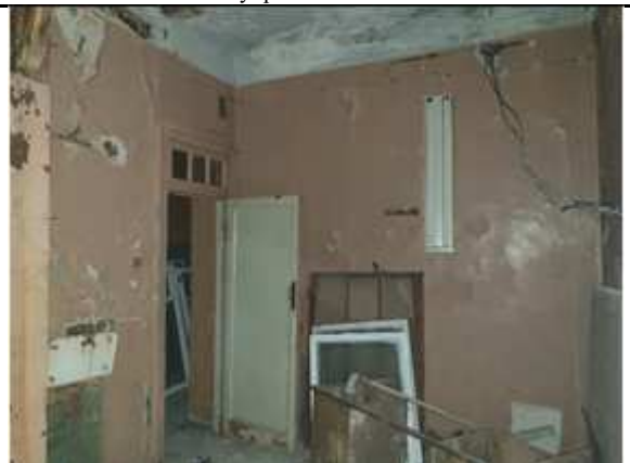
Фото № 22: Внутреннее состояние Объекта
