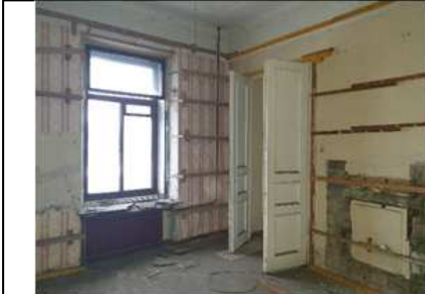
Фото № 11: Внутреннее состояние Объекта
