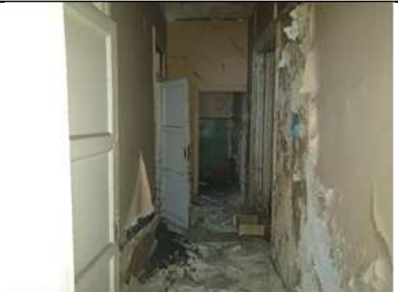
Фото №20: Внутреннее состояние Объекта
