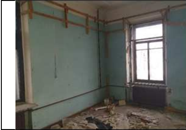
Фото №9: Внутреннее состояние Объекта
