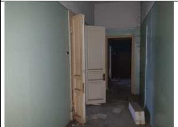
Фото № 14: Внутреннее состояние Объекта
