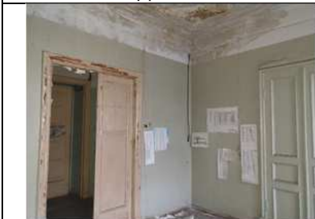
Фото № 15: Внутреннее состояние Объекта
