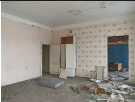
Фото № 19: Внутреннее состояние Объекта
