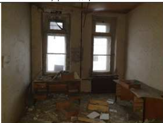
Фото № 23: Внутреннее состояние Объекта
