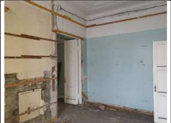
Фото № 12: Внутреннее состояние Объекта
