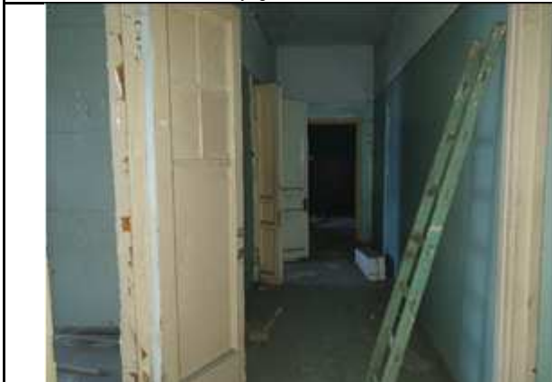
Фото № 13: Внутреннее состояние Объекта
