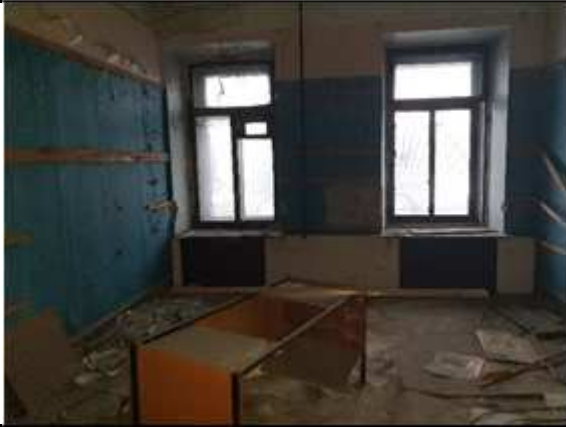
Фото № 17 Внутреннее состояние Объекта
