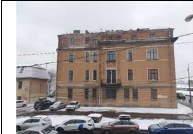
Фото №1: Внешний вид здания
