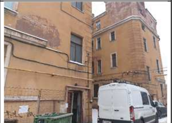
Фото №4: Вход через соседнее помещение 1-Н
