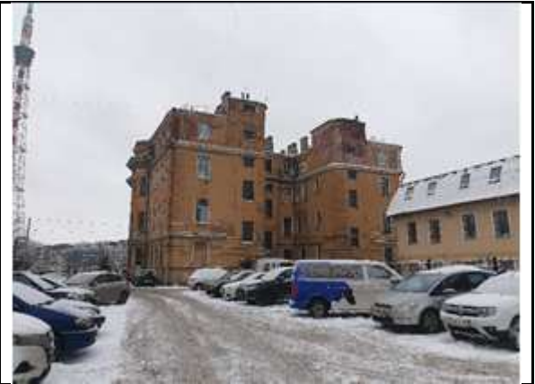
Фото №2: Внешний вид здания
