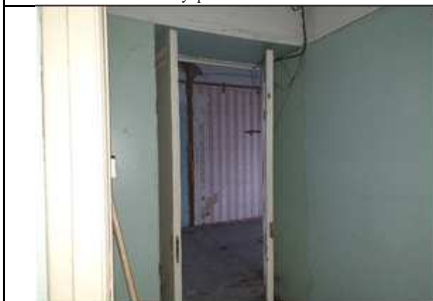
Фото №7: Внутреннее состояние Объекта
