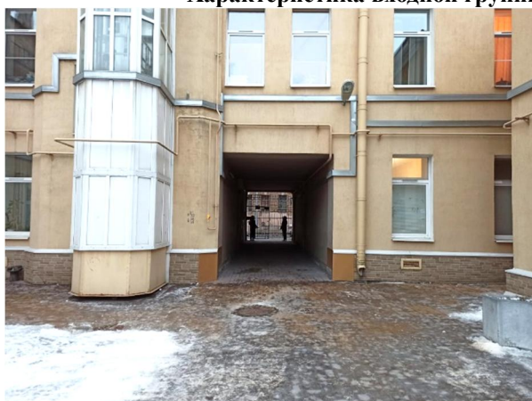
Фото 7. Доступ к Объекту оценки через арку
