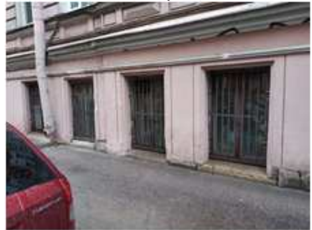
Фото 10. Оконные проемы, направленные на улицу
