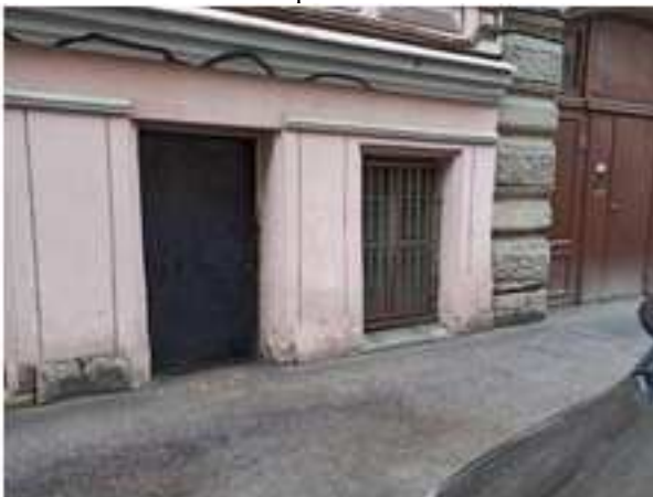
Фото 11. Отдельный вход с улицы и оконные проемы
