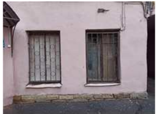
Фото 12. Оконные проемы, направленные во двор
