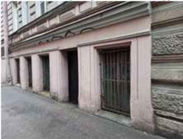
Фото 9. Отдельный вход с улицы и оконные проемы
