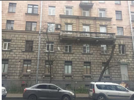
Фото 7. Вид здания расположения Объекта оценки
