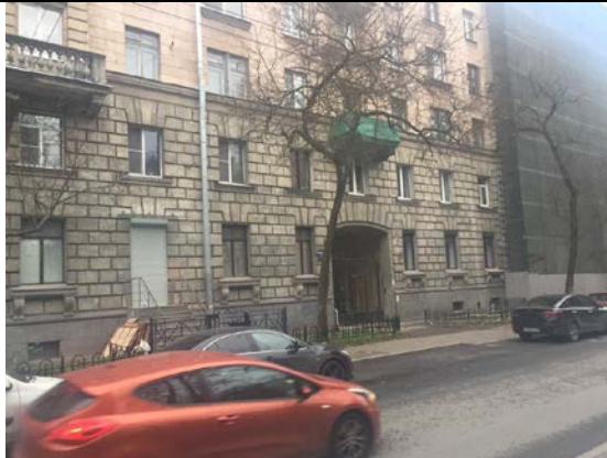
Фото 8. Вид здания расположения Объекта оценки
