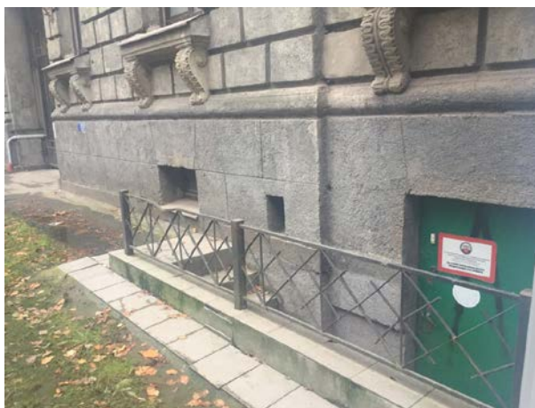
Фото 9. Вид отдельного входа Объекта оценки
