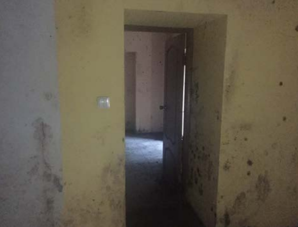
Фото 15. Типичное состояние Объекта оценки
