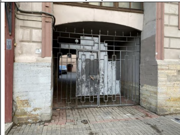
Фото 9. Арка, через которую осуществляется проход со двора к Объекту оценки.
