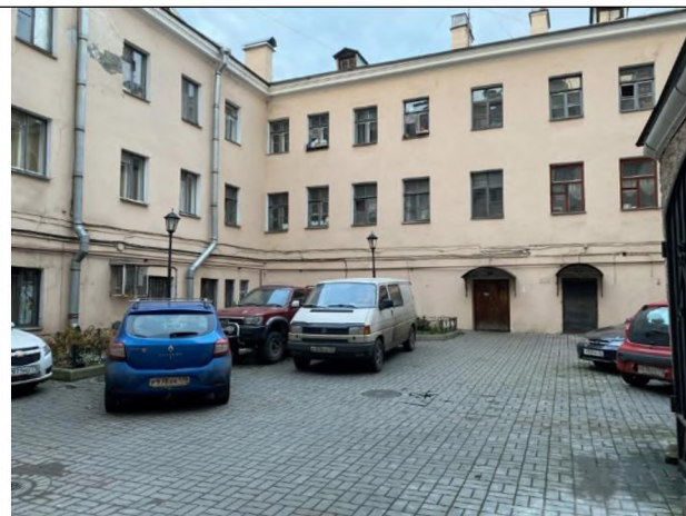
Фото 12. Дворовое окружение Объекта оценки.
