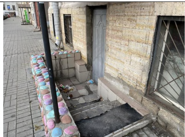
Фото 8. Отдельный вход с улицы в Объект оценки.
