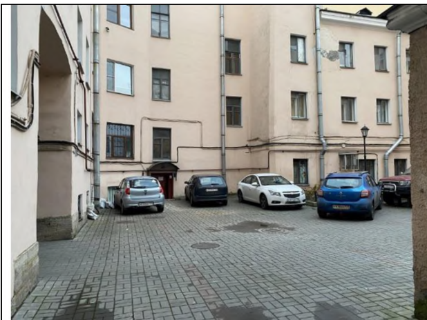
Фото 11. Дворовое окружение Объекта оценки.
