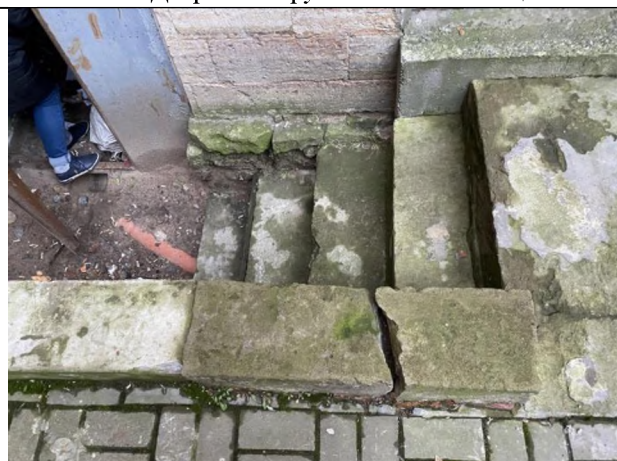
Фото 14. Вход в Объект оценки со двора.
