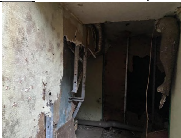
Фото 15. Состояние внутренней отделки Объекта оценки.
