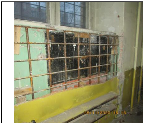
Фото 17. Состояние внутренней отделки Объекта оценки.
