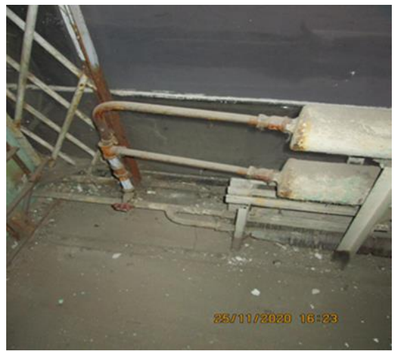
Фото 14. Состояние внутренней отделки Объекта оценки.
