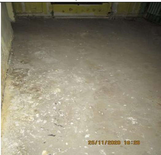
Фото 27. Состояние внутренней отделки Объекта оценки.
