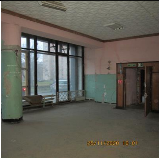
Фото 11. Состояние внутренней отделки Объекта оценки.
