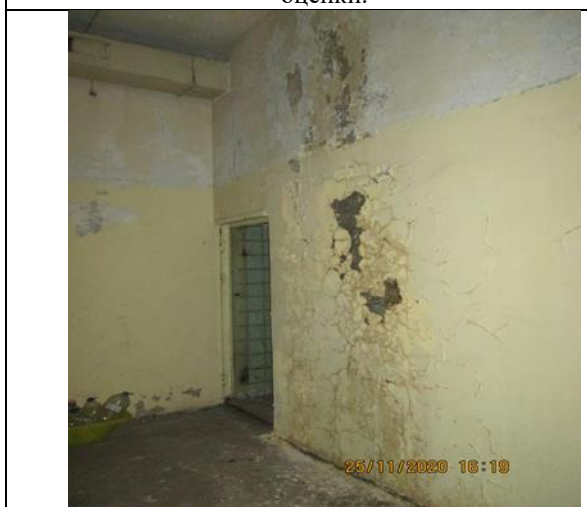
Фото 19. Состояние внутренней отделки Объекта оценки.
