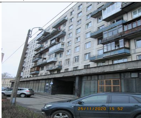
Фото 2. Здание размещения Объекта оценки.
