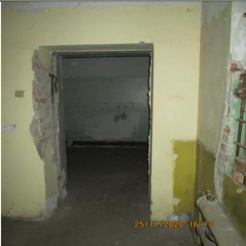
Фото 23. Состояние внутренней отделки Объекта оценки.
