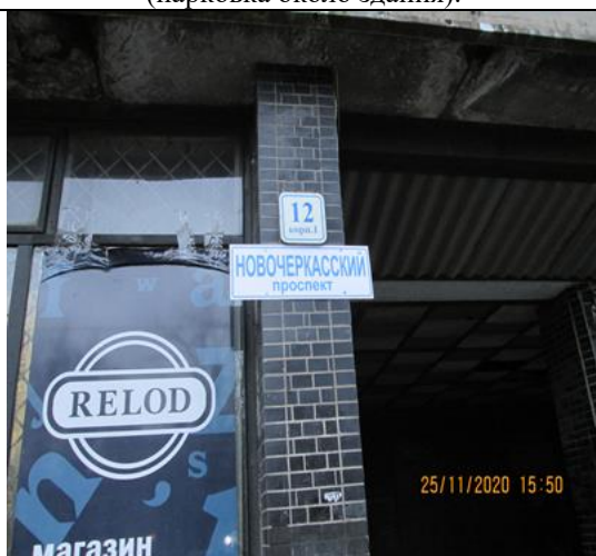
Фото 3. Адресная табличка на фасадной части здания.
