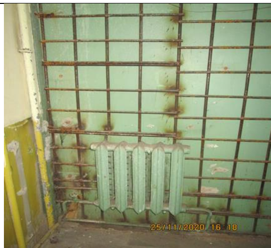
Фото 18. Состояние внутренней отделки Объекта оценки.
