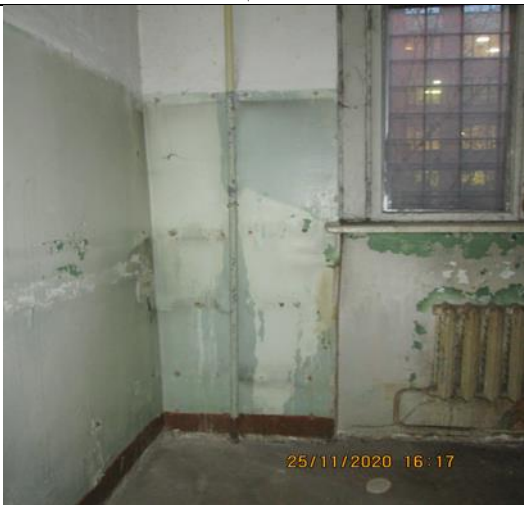
Фото 25. Состояние внутренней отделки Объекта оценки.
