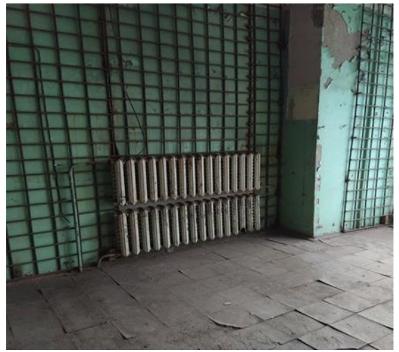
Фото 12. Состояние внутренней отделки Объекта оценки.
