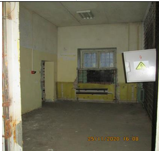
Фото 15. Состояние внутренней отделки Объекта оценки.
