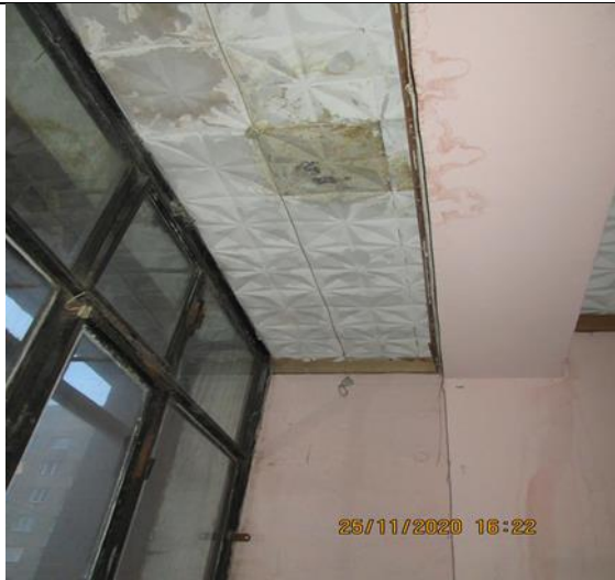
Фото 13. Состояние внутренней отделки Объекта оценки.
