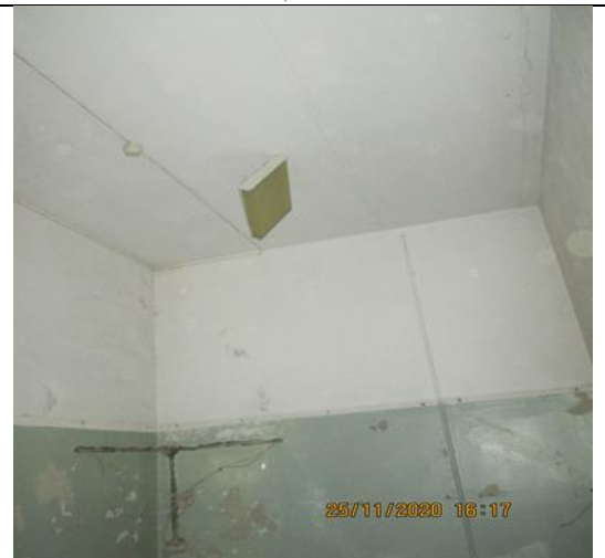
Фото 26. Состояние внутренней отделки Объекта оценки.
