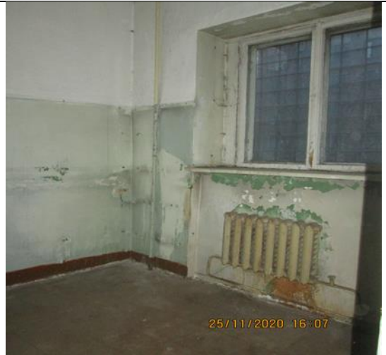
Фото 24. Состояние внутренней отделки Объекта оценки.
