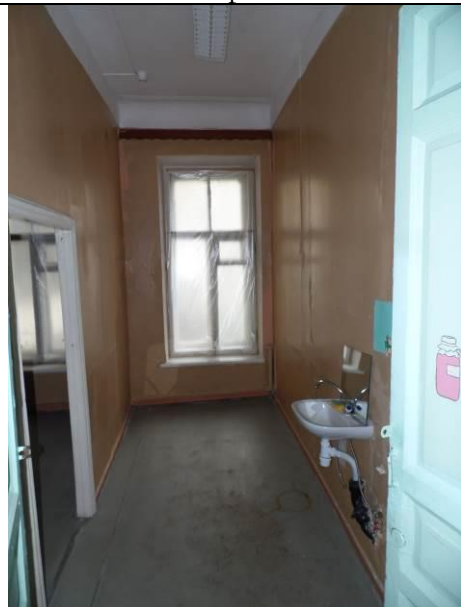
Фото 56 Состояние помещения (санузел)
