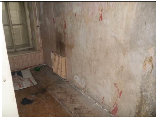
Состояние помещения (ч.п. 10)
