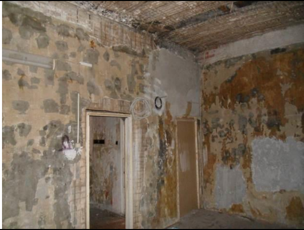
Фото 143 Состояние помещения (ч.п. 9)
