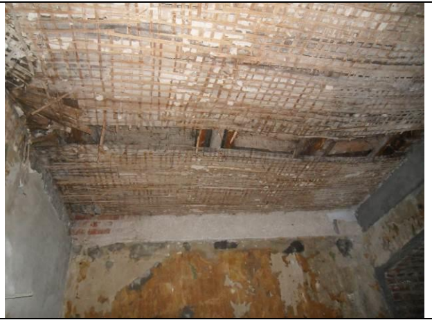
Фото 141 Состояние помещения (потолок ч.п. 9)
