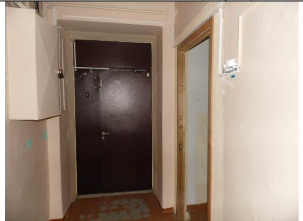
Фото 122 Состояние помещения, входная дверь на лестничную клетку
