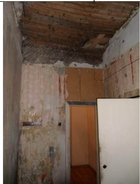
Состояние помещения (ч.п. 10)
