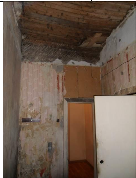
Состояние помещения (ч.п. 10)
