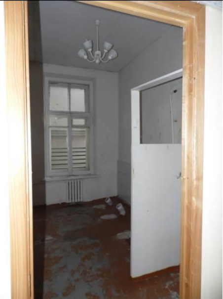
Фото 120 Состояние помещения (санузел)
