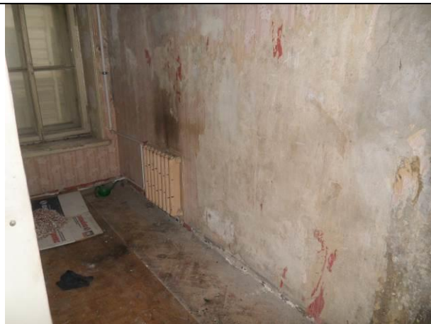
Состояние помещения (ч.п. 10)
