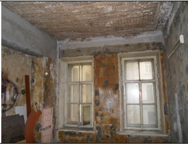
Состояние помещения (ч.п. 9) Фото 142
