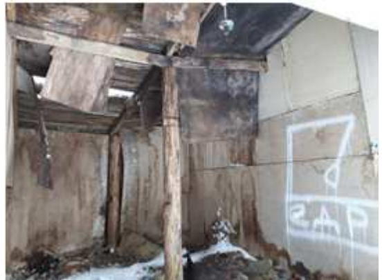
Фото 78. Внутреннее состояние Объекта оценки
