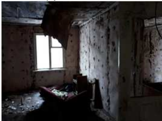
Фото 71. Внутреннее состояние Объекта оценки
