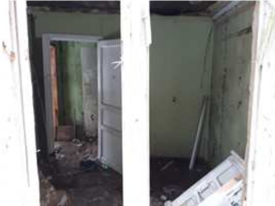
Фото 69. Внутреннее состояние Объекта оценки
