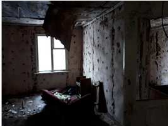
Фото 71. Внутреннее состояние Объекта оценки
