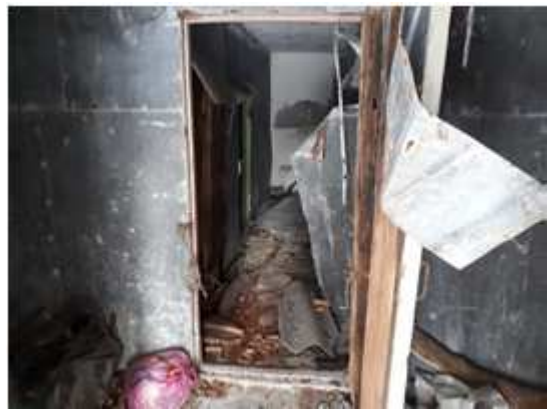
Фото 76. Внутреннее состояние Объекта оценки
