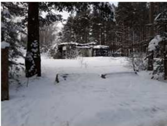
Фото 7. Подъездные пути, вид территории Объекта оценки
