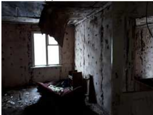
Фото 72. Внутреннее состояние Объекта оценки
