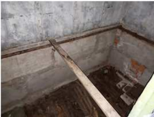
Фото 77. Внутреннее состояние Объекта оценки
