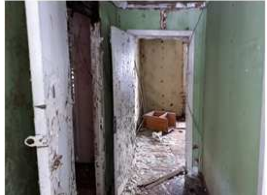
Фото 70. Внутреннее состояние Объекта оценки
