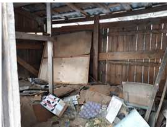
Фото 73. Внутреннее состояние Объекта оценки
