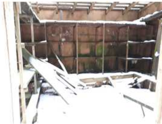
Фото 75. Внутреннее состояние Объекта оценки
