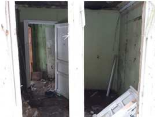
Фото 69. Внутреннее состояние Объекта оценки
