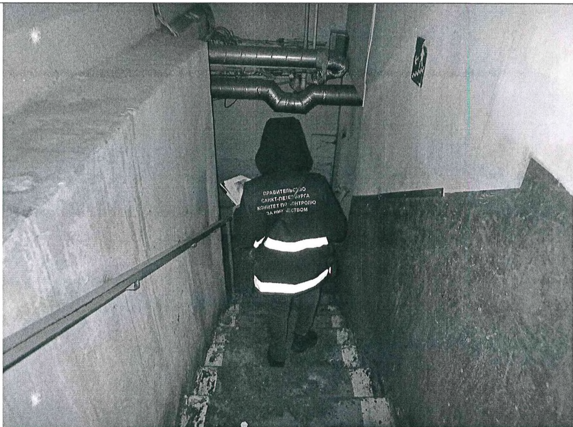
Описание: Вход в подвал помещения 8-Н Объекта
