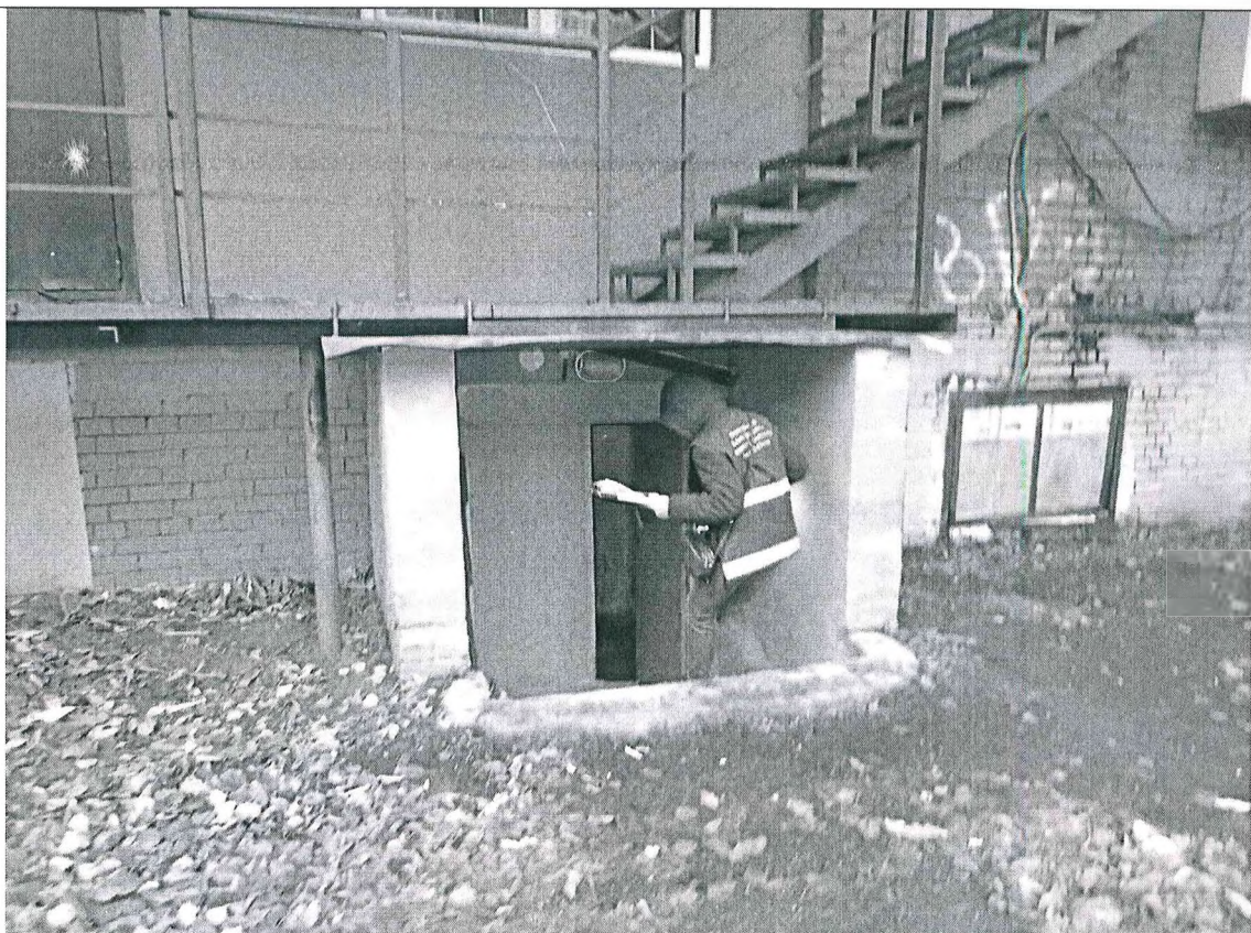
Описание: Вход в подвал помещения 8-Н Объекта
