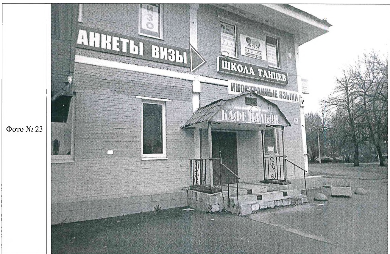
Описание: Вход в ч.п. 11 помещения 8-Н Объекта
