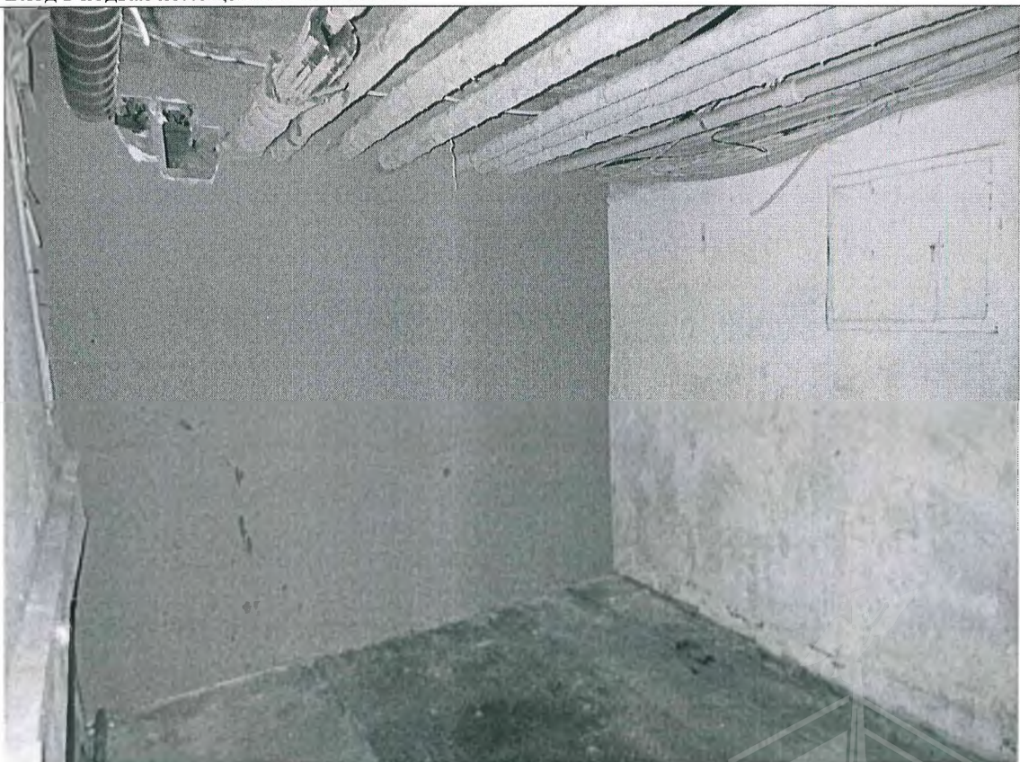
Описание: В ч.п. 47 помещения 8-Н Объекта возведена перегородка
