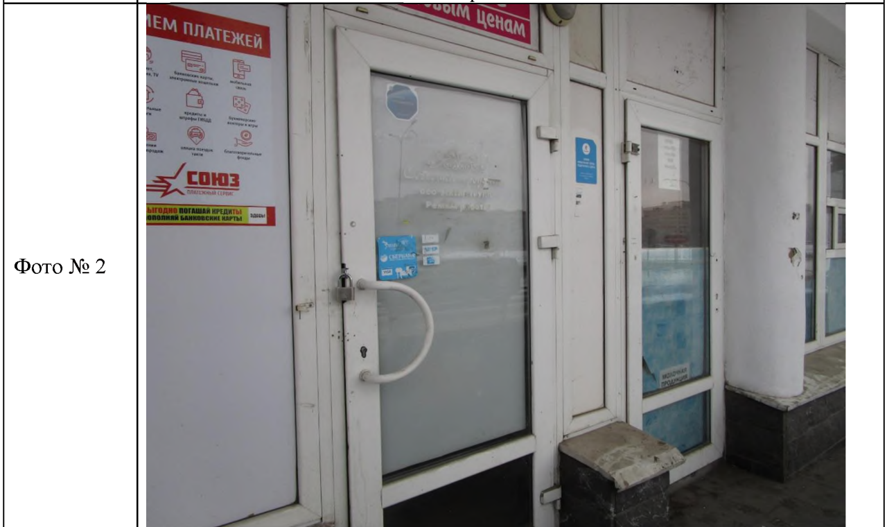
Описание: Вход на Объект отдельный с улицы
