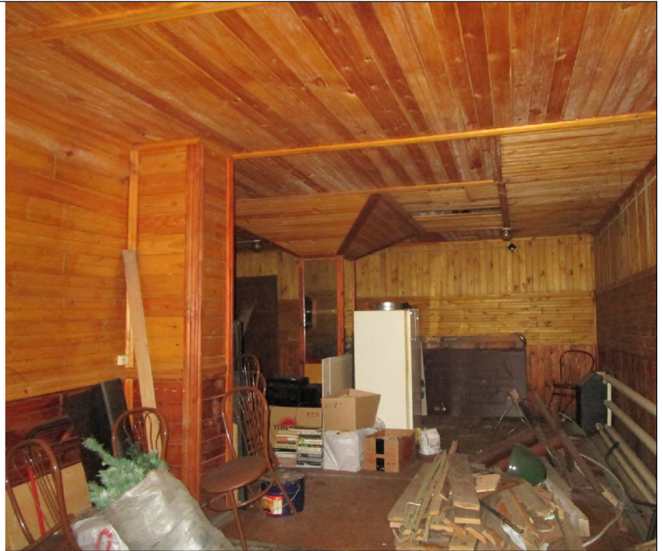
Описание: Вид внутри Объекта (ч.п. 4)
