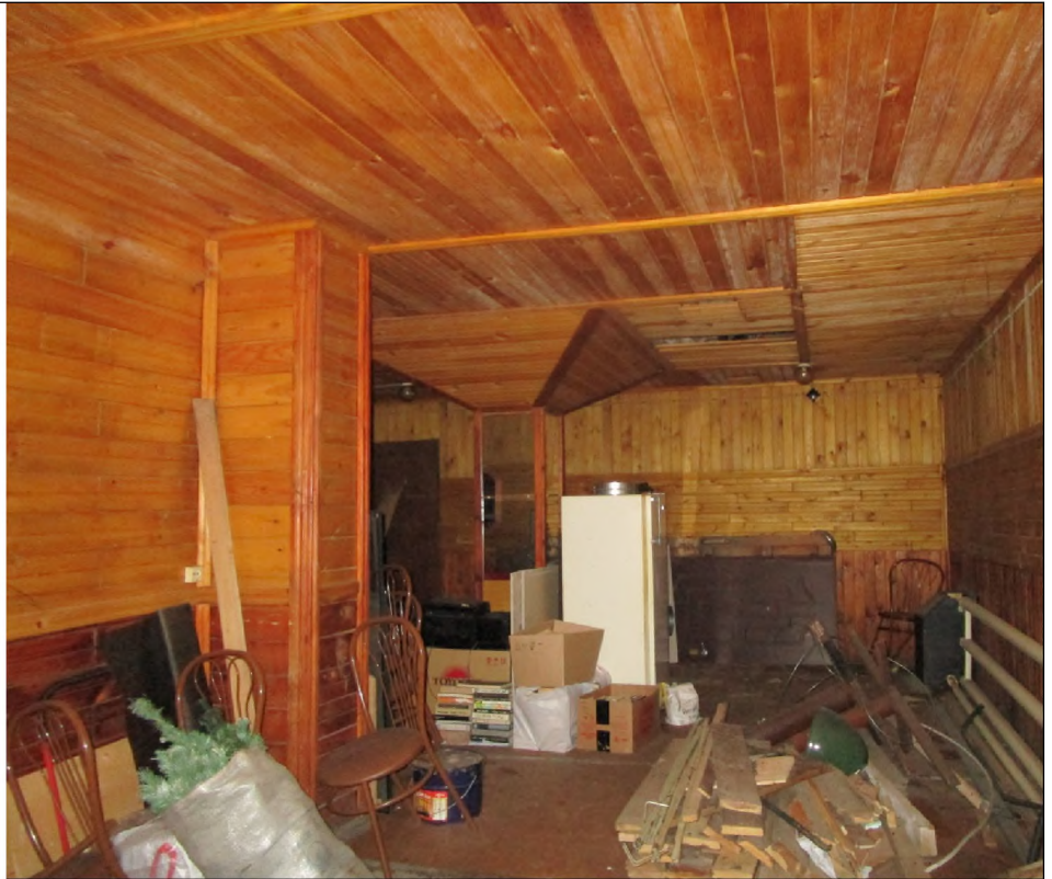
Описание: Вид внутри Объекта (ч.п. 4)
