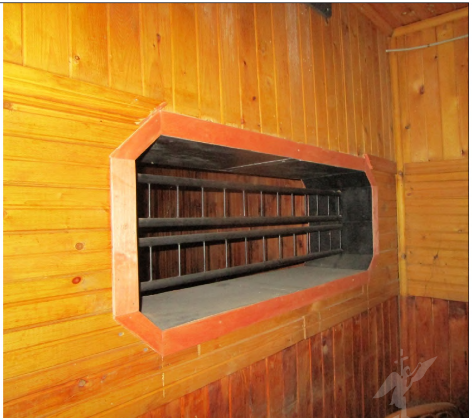
Описание: Вид внутри Объекта (в ч.п. 5 оборудован оконный проем)
