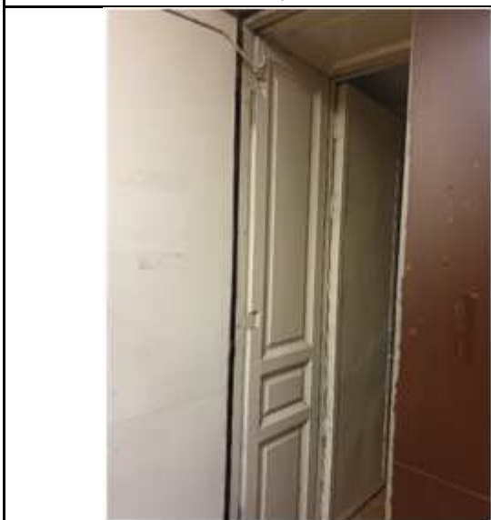
Вход в пом. 44-Н
