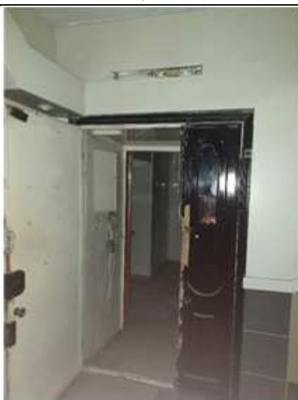
Вход в пом. 10-Н
