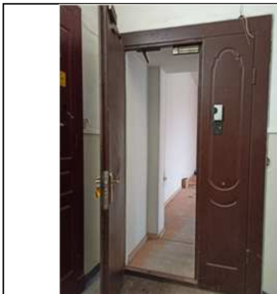
Вход в пом. 39-Н
