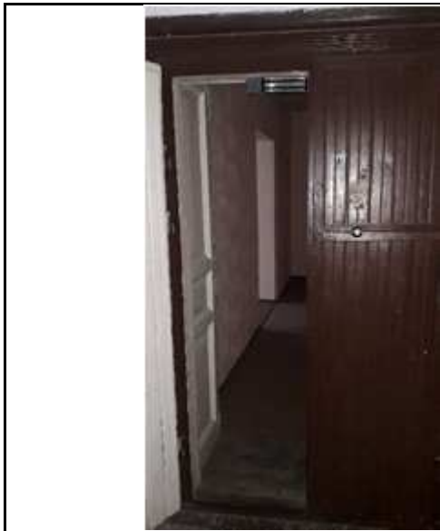
Вход в пом. 87-Н
