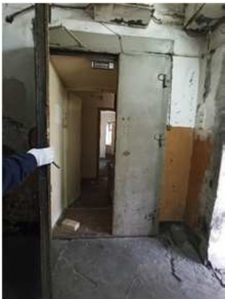
Вход в пом. 19-Н
