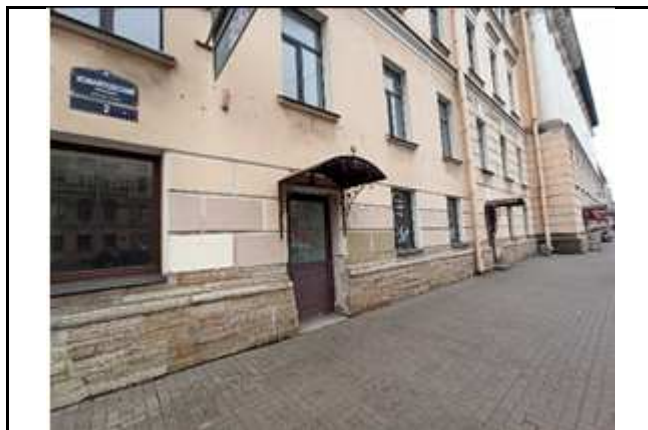
Входы в пом. 24-Н с улицы
