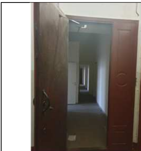
Вход в пом. 47-Н
