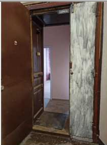
Вход в пом. 37-Н
