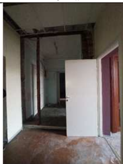
Вход в пом. 71-Н через 87-Н
