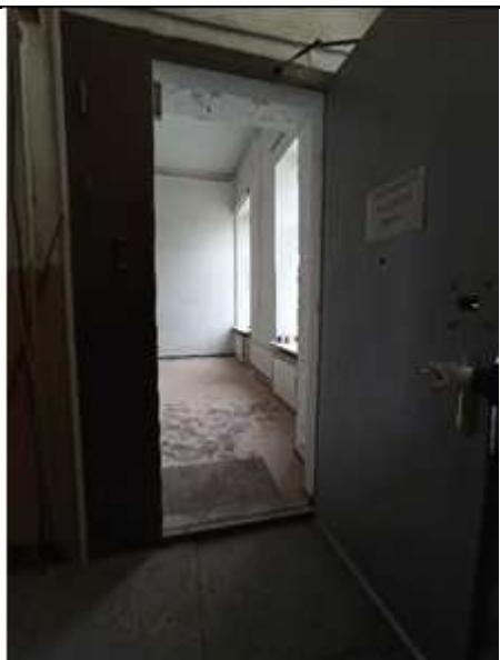
Вход в пом. 50-Н
