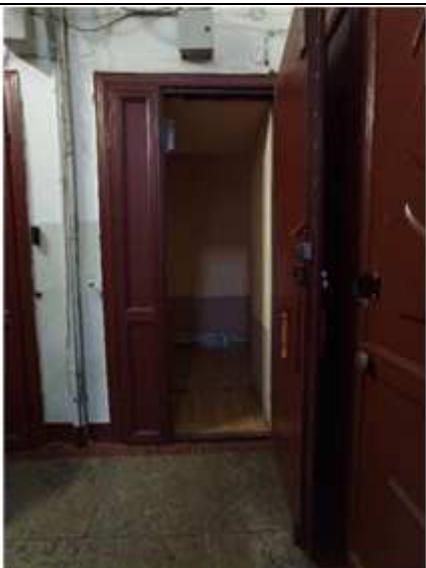
Вход в пом. 46-Н
