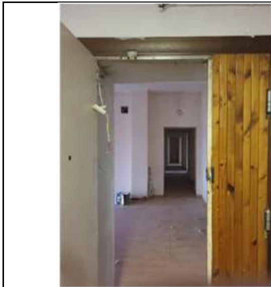
Вход в пом. 67-Н
