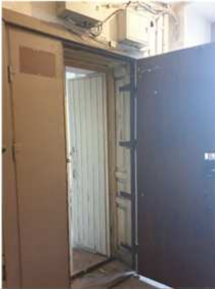
Вход в пом. 35-Н
