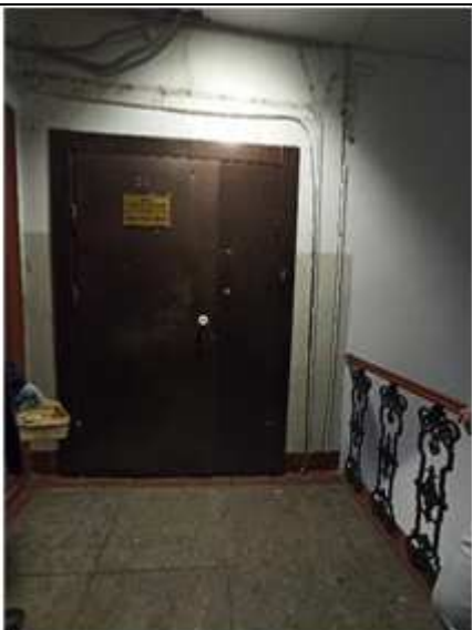
Вход в пом. 66-Н
