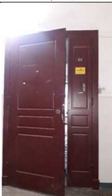
Вход в пом. 40-Н
