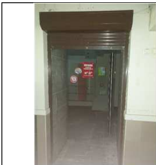
Вход в пом. 15-Н
