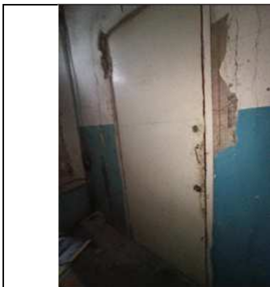
Вход в пом. 79-Н
