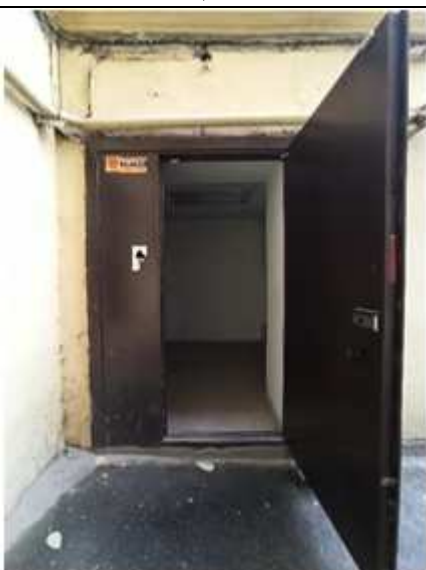
Вход в пом. 14-Н
