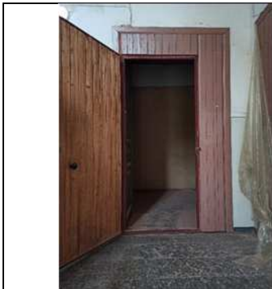
Вход в пом. 53-Н
