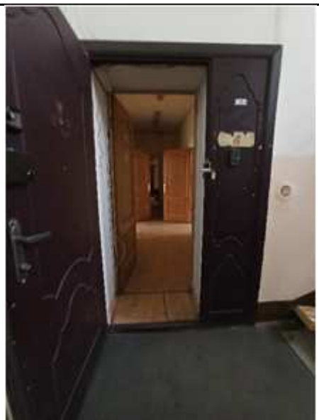
Вход в пом. 51-Н
