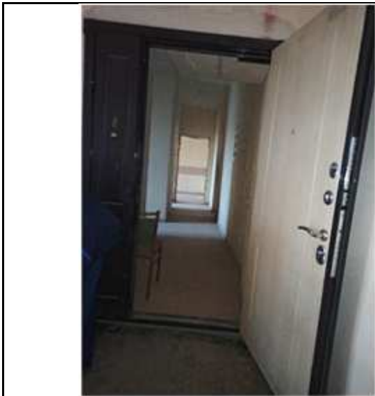
Вход в пом. 64-Н
