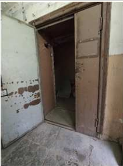
Вход в пом. 17-Н
