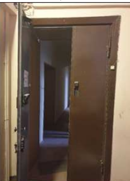
Вход в пом. 48-Н
