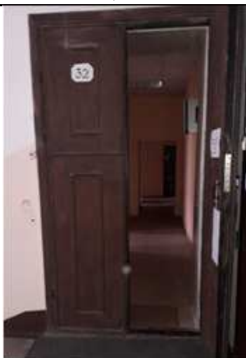
Вход в пом. 52-Н
