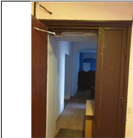
Вход в пом. 68-Н
