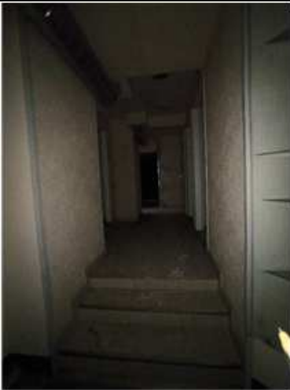
Вход в пом. 16-Н через пом. 15-Н
