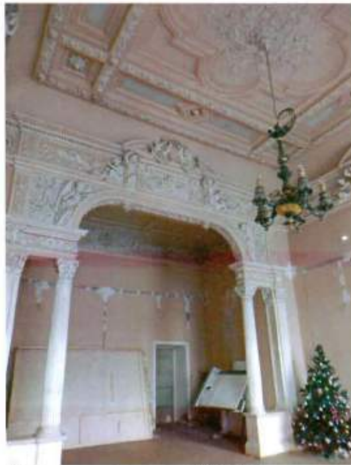
16. Интерьеры (помещение 1-Н(168)).
