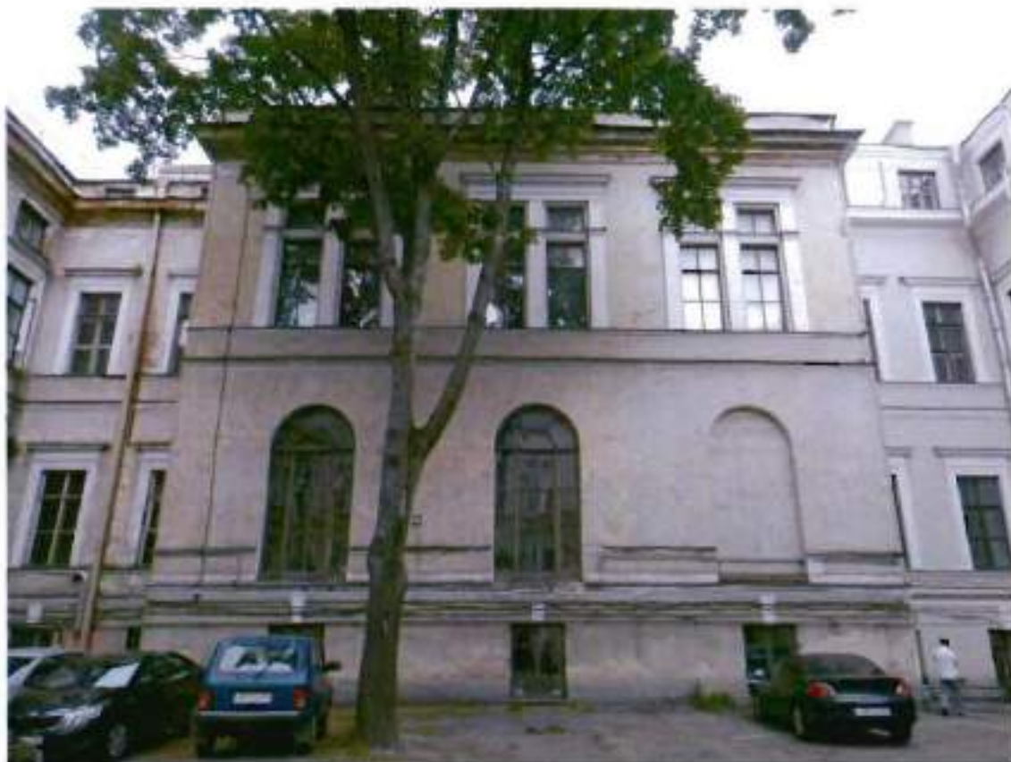
5. Восточный фасад внутреннего двора
