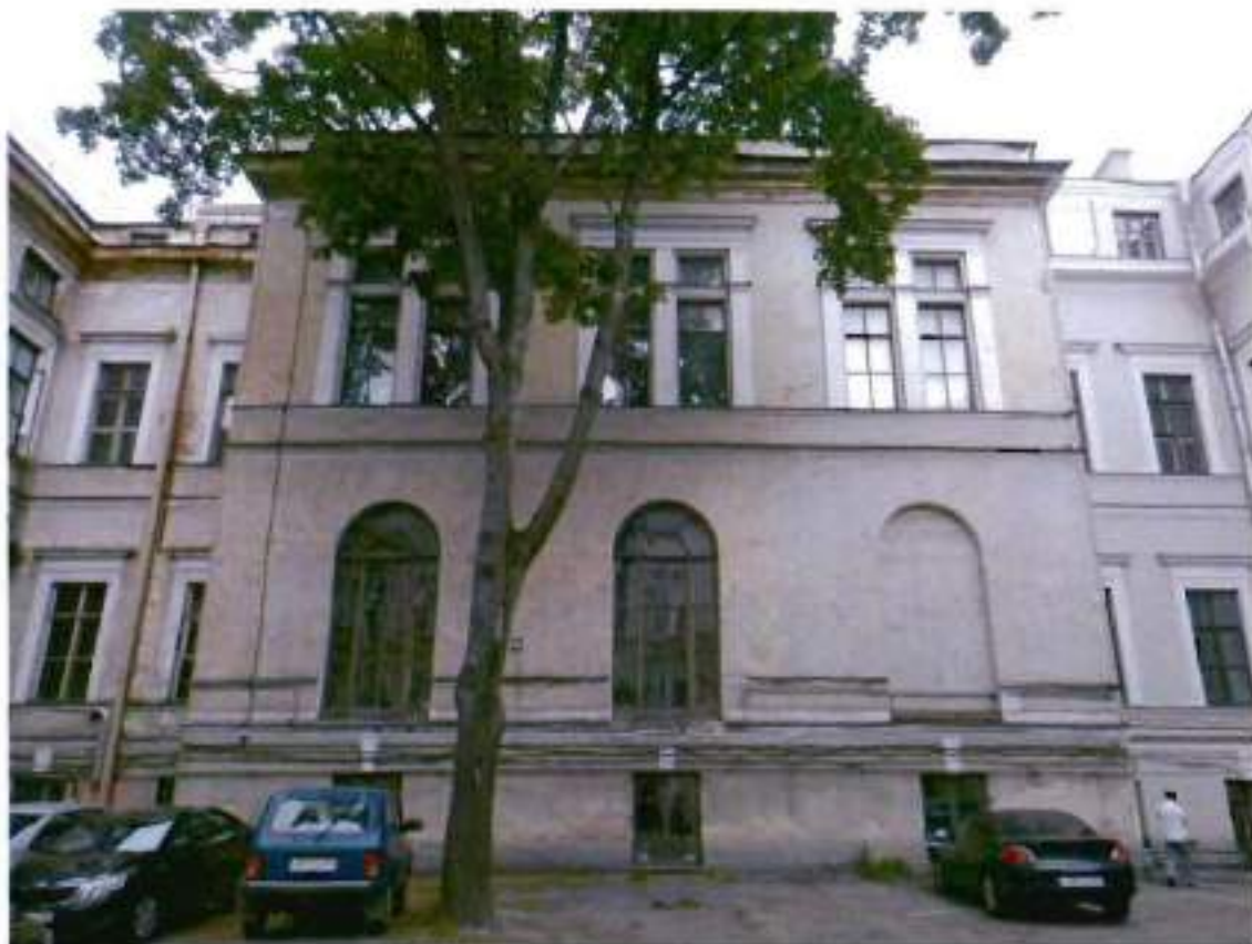
5. Восточный фасад внутреннего двора
