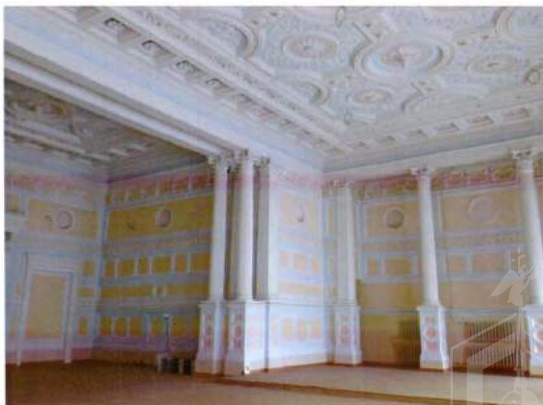
12. Интерьеры (помещение 1-Н(163)).
