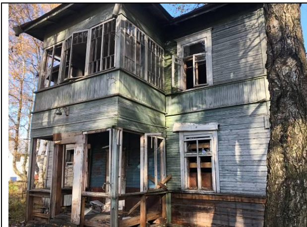
Фото 1. Вид на здание размещения Объекта оценки.
