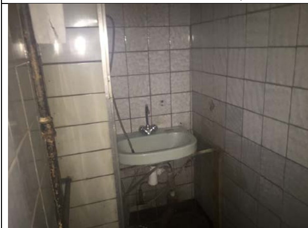
Фото 37. Типичное состояние Объекта оценки
