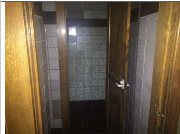
Фото 35. Типичное состояние Объекта оценки
