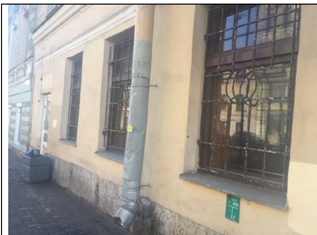
Фото 9. Вид здания Объекта оценки
