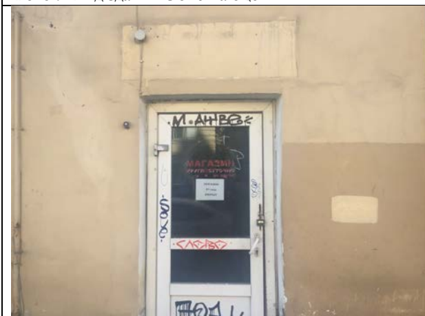
Фото 11. Вход в здание Объекта оценки (с улицы)
