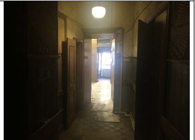
Фото 20. Проход в соседнее здание
