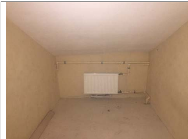
Фото 19. Типичное состояние Объекта оценки
