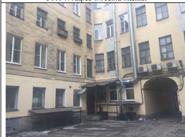
Фото 11. Внутри дворовая территория жилого дома, в котором расположен Объект оценки
