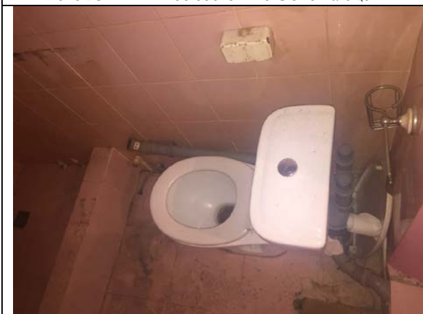
Фото 25. Типичное состояние Объекта оценки
