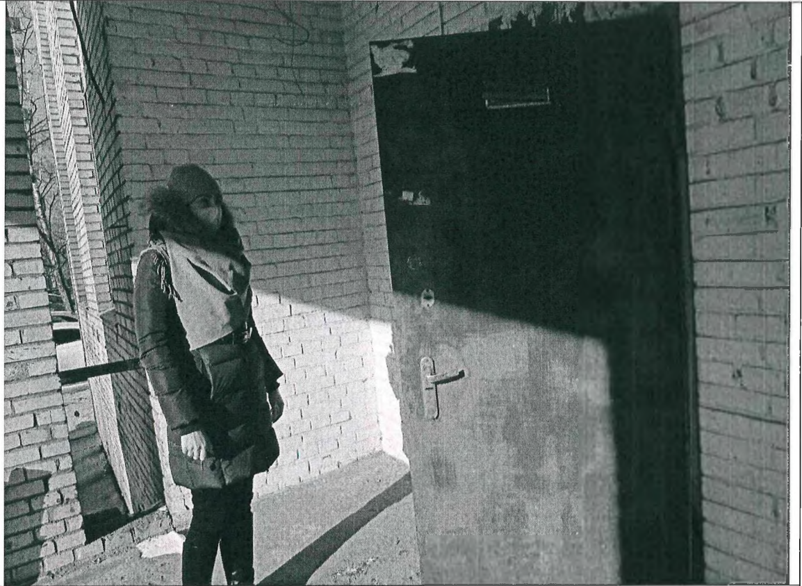
Описание: Вход в Объект
