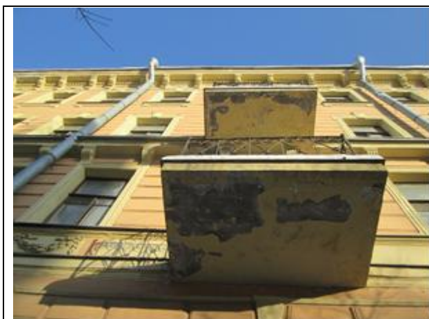
Фото 7. Состояние уличного фасада здания Объекта оценки
