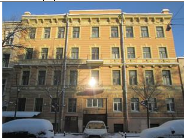
Фото 1. Общий вид здания с улицы
