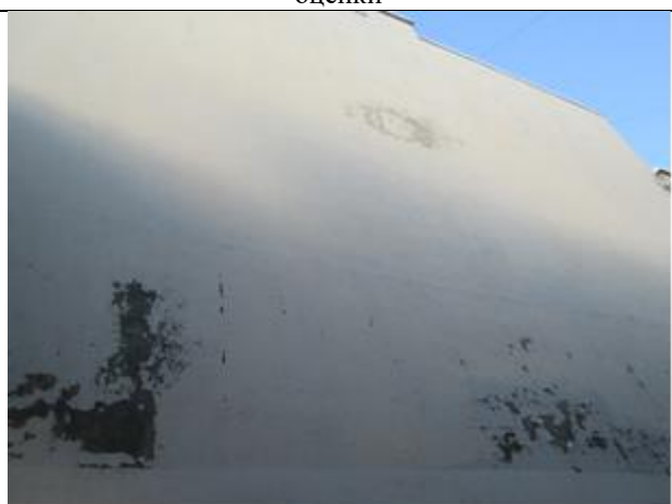
Фото 10. Состояние уличного фасада здания Объекта оценки
