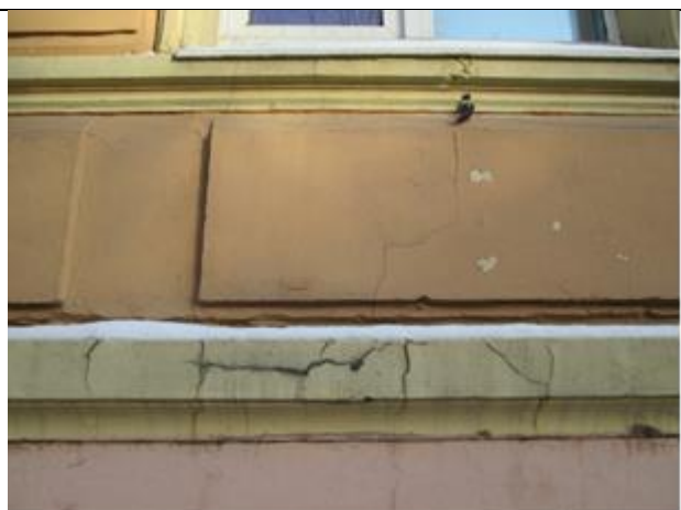
Фото 8. Состояние уличного фасада здания Объекта оценки
