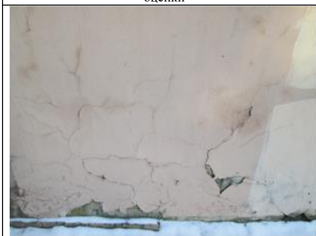
Фото 9. Состояние уличного фасада здания Объекта оценки
