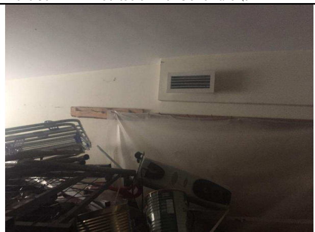
Фото 38. Типичное состояние Объекта оценки
