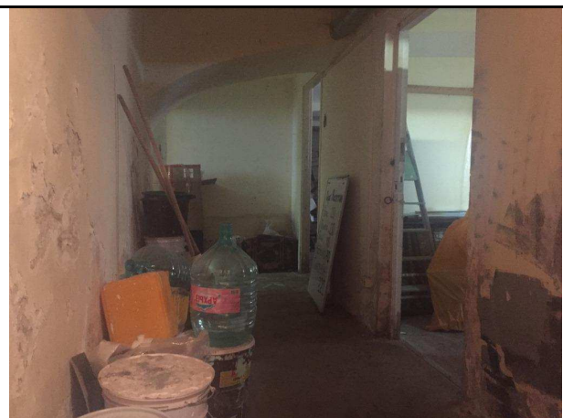
Фото 50. Типичное состояние Объекта оценки
