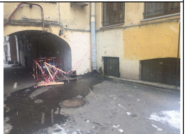
Фото 12. Вид арки со двора здания нахождения Объекта оценки
