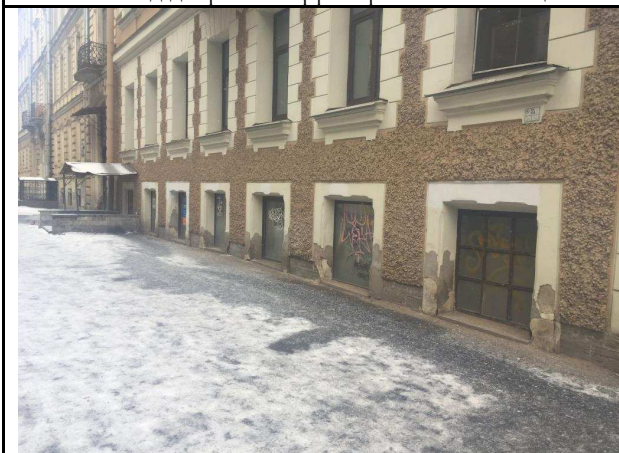
Фото 19. Вид оконной группы, выходящей на улицу Объекта оценки
