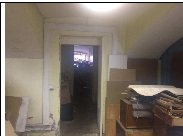
Фото 33. Типичное состояние Объекта оценки
