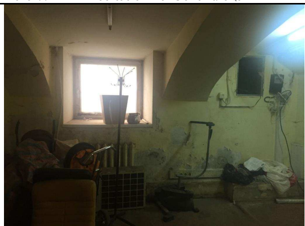
Фото 46. Типичное состояние Объекта оценки
