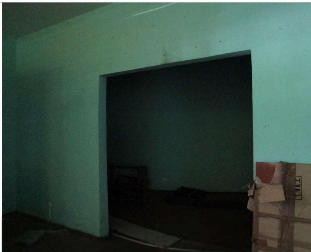
Описание: Вид внутри Объекта (ч.п. 5)
