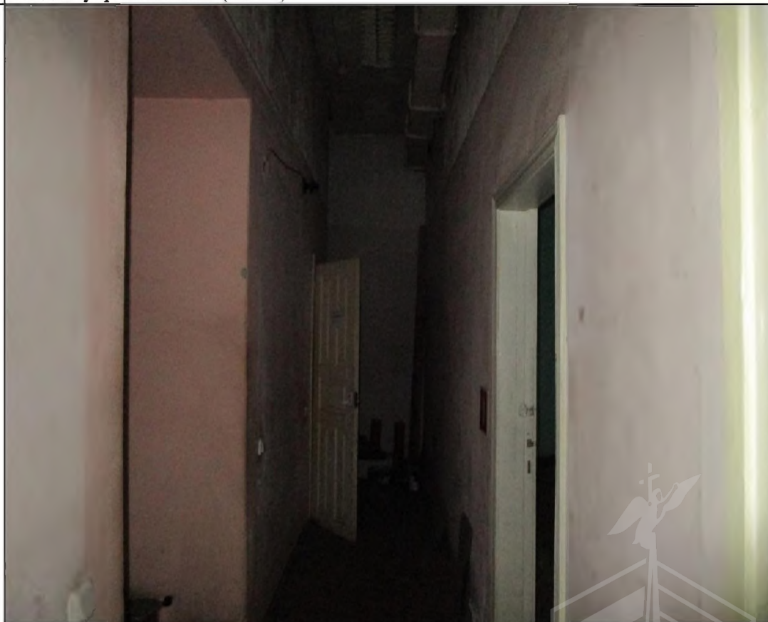
Описание: Вид внутри Объекта (ч.п. 9)
