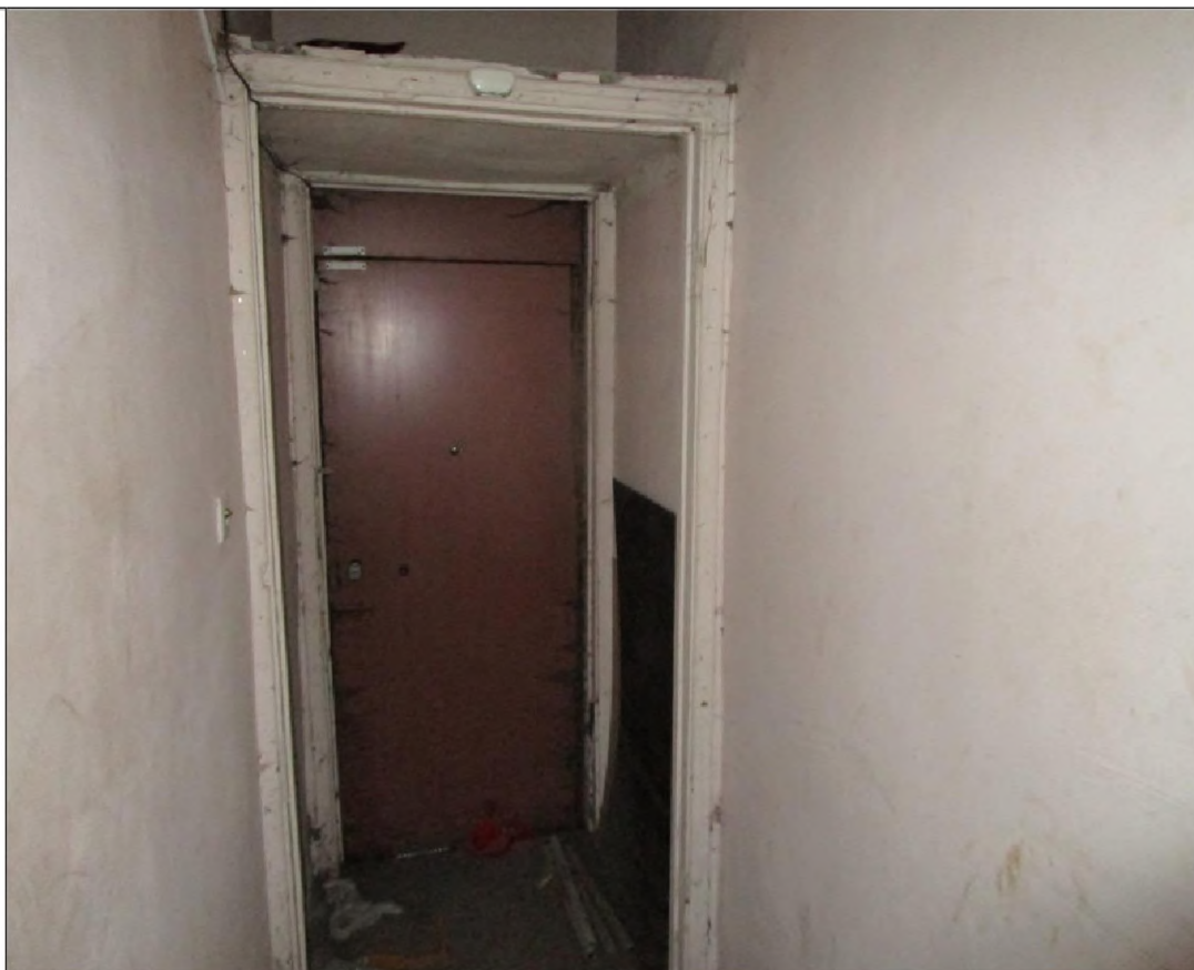
Описание: Вид внутри Объекта (ч.п. 12)
