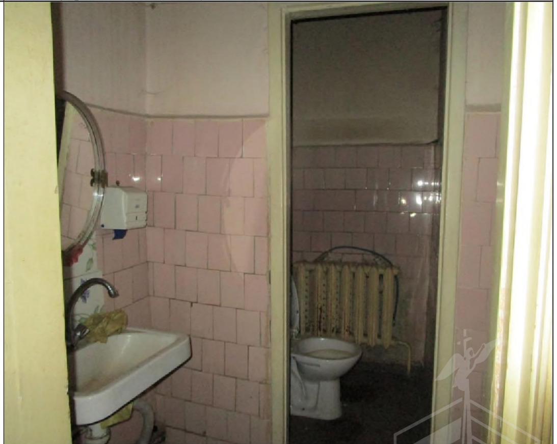
Описание: Вид внутри Объекта (ч.п. 10, 11)
