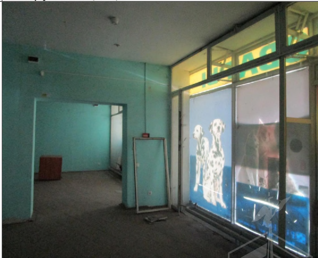
Описание: Вид внутри Объекта (ч.п. 2)
