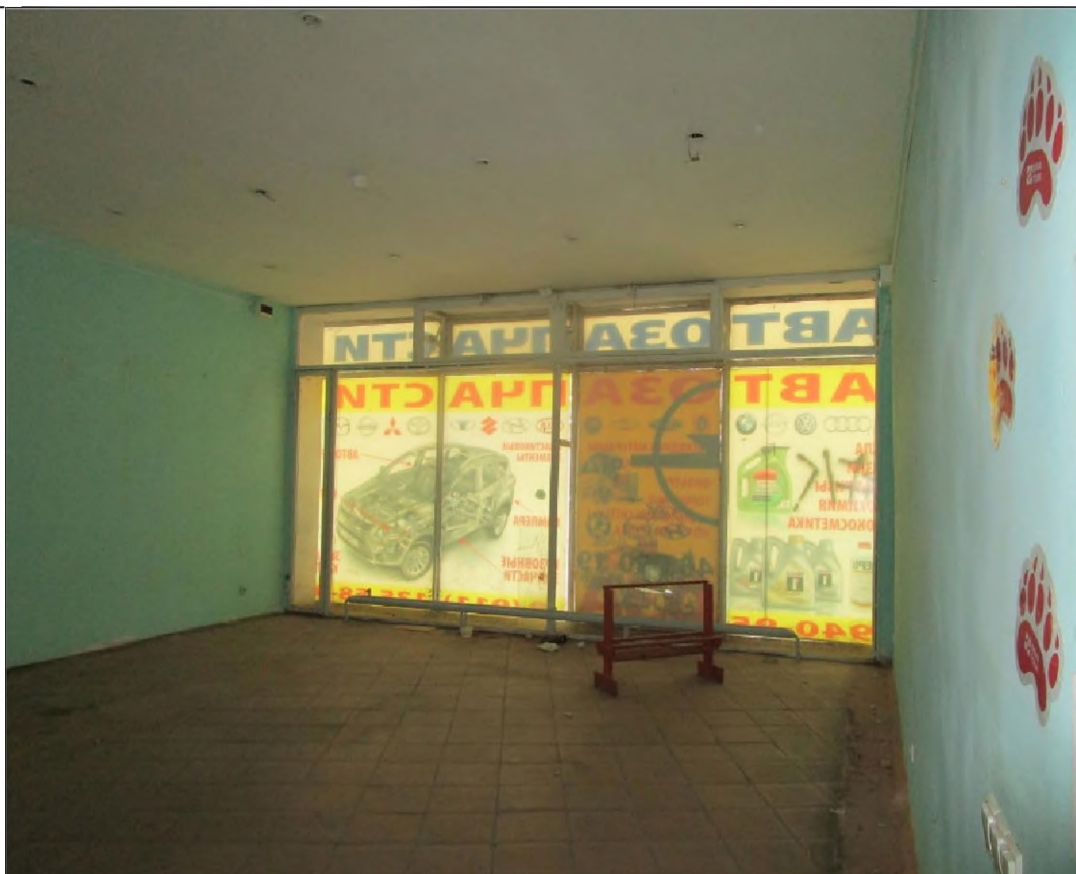
Описание: Вид внутри Объекта (ч.п. 4)
