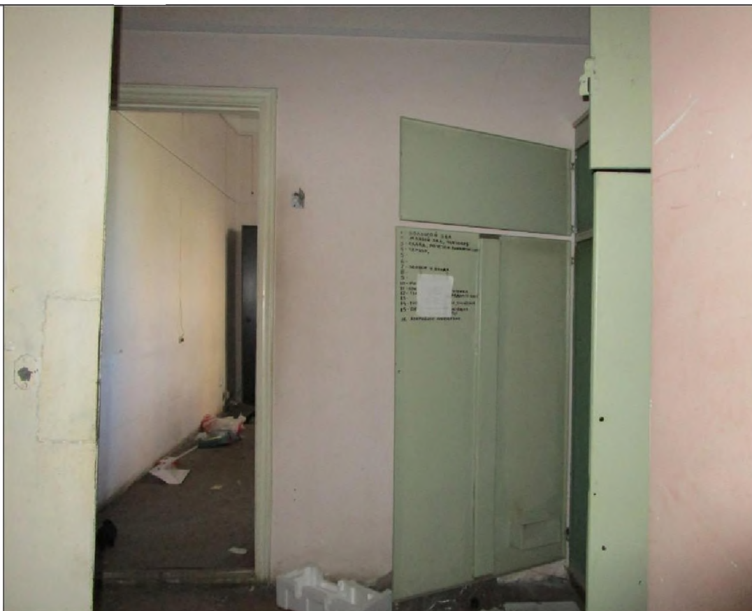
Описание: Вид внутри Объекта (ч.п. 8)
