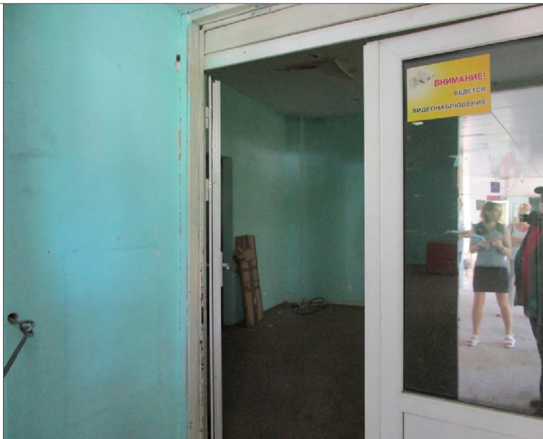
Описание: Вид внутри Объекта (ч.п. 1)
