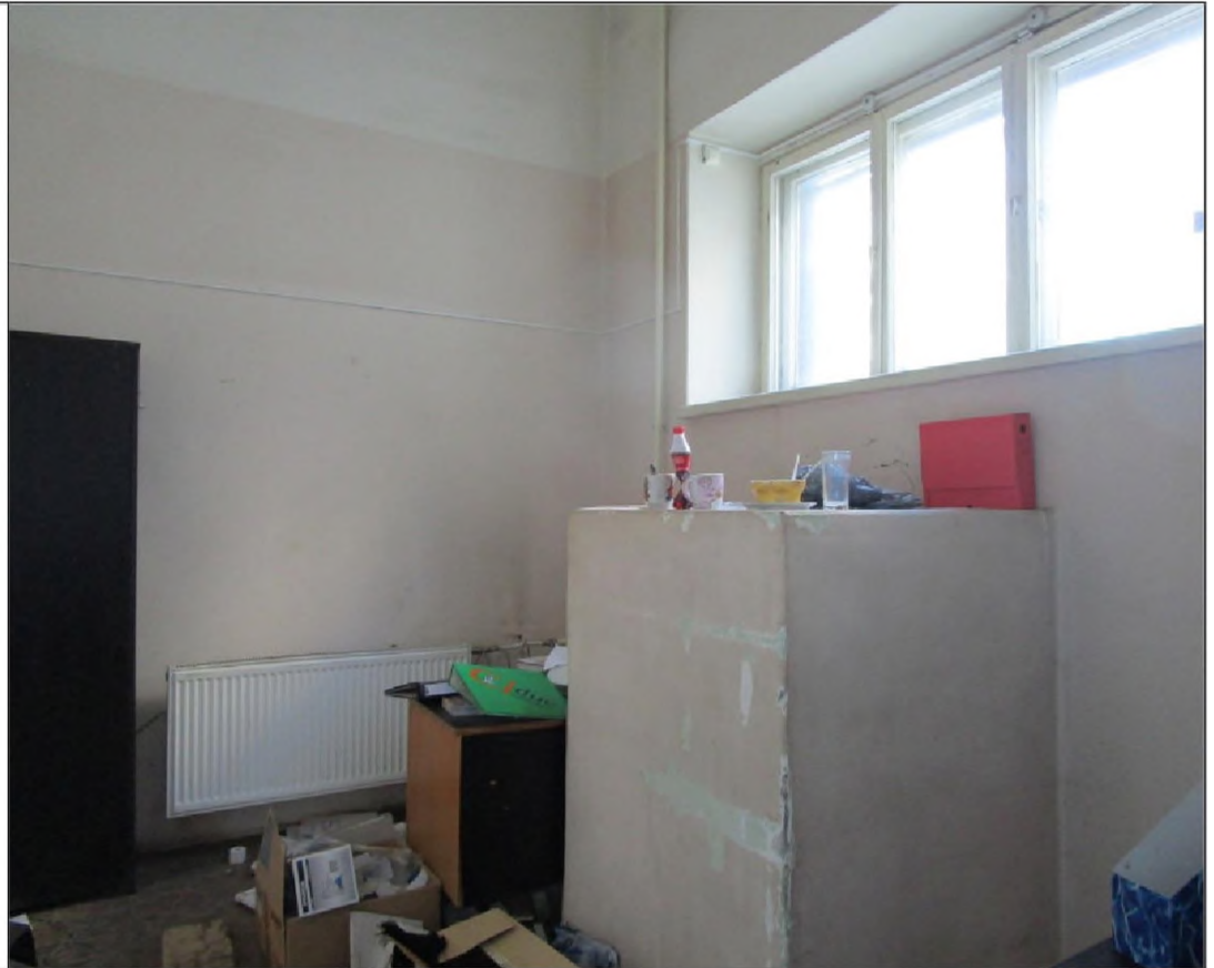
Описание: Вид внутри Объекта (ч.п. 7)
