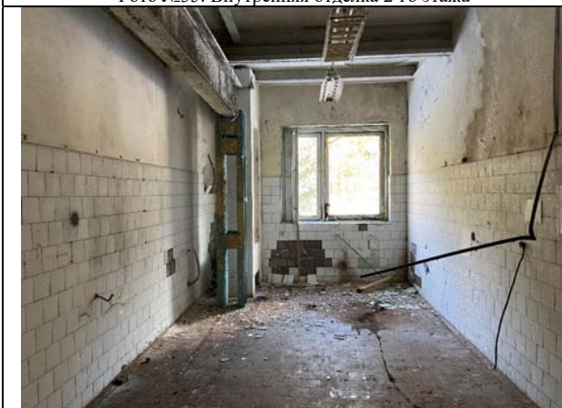
Фото №37: Внутренняя отделка 2-го этажа
