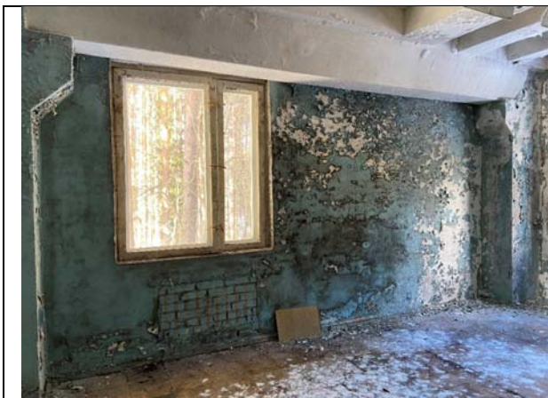
Фото №39: Внутренняя отделка 2-го этажа
