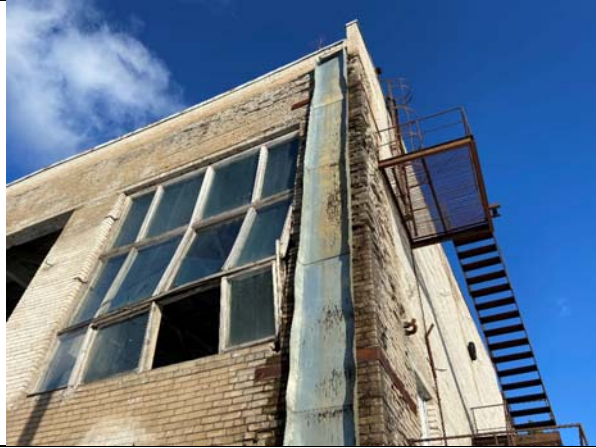
Фото №15: Фасад здания
