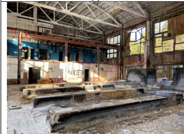
Фото №25: Внутренняя отделка
