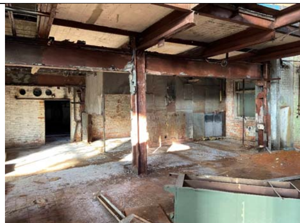
Фото №32: Внутренняя отделка
