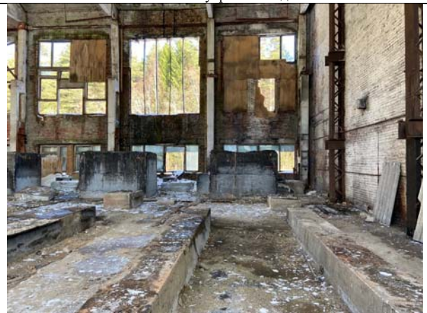
Фото №26: Внутренняя отделка
