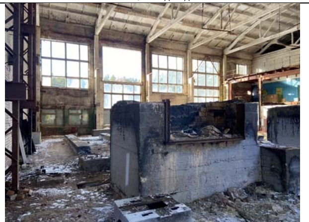
Фото №20: Внутренняя отделка
