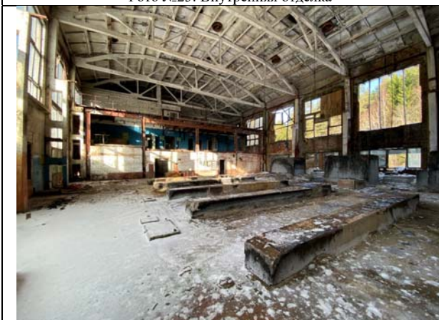
Фото №27: Внутренняя отделка
