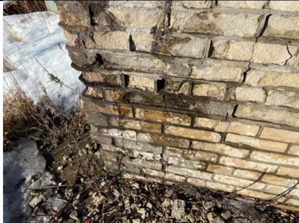
Фото №17: Фасад здания
