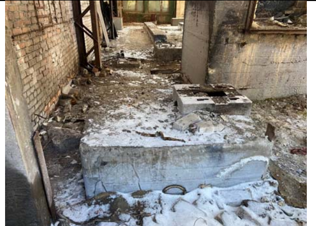
Фото №18: Вход в здание
