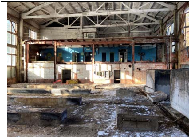
Фото №23: Внутренняя отделка
