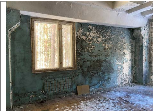
Фото №39: Внутренняя отделка 2-го этажа
