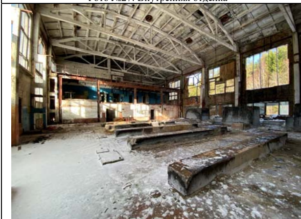
Фото №29: Внутренняя отделка
