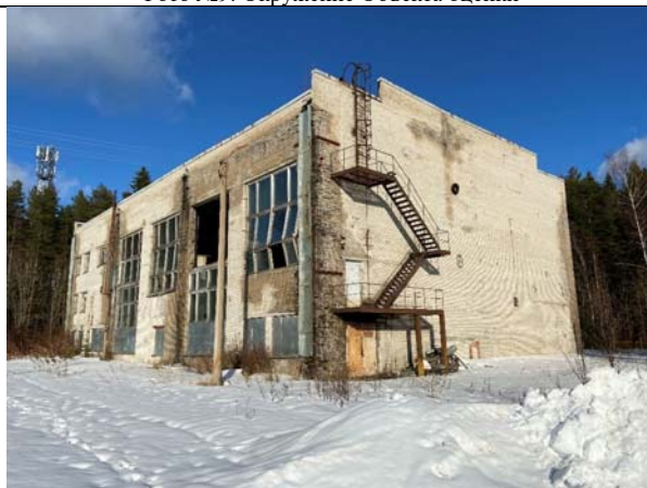
Фото №11: Фасад здания
