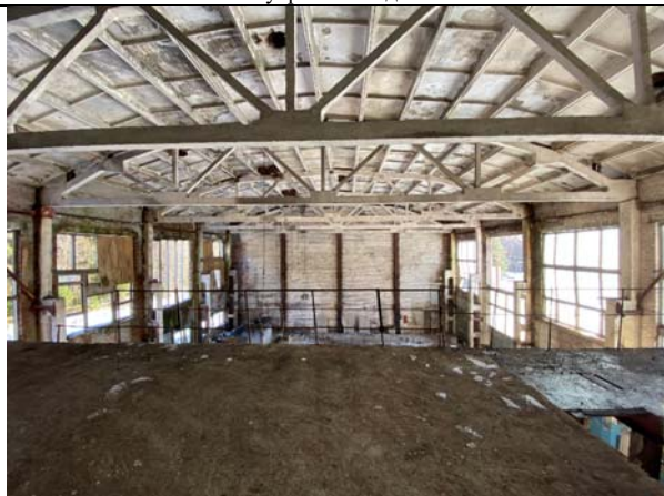
Фото №41: Внутренняя отделка 3-го этажа
