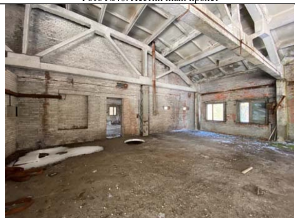
Фото №42: Внутренняя отделка 3-го этажа
