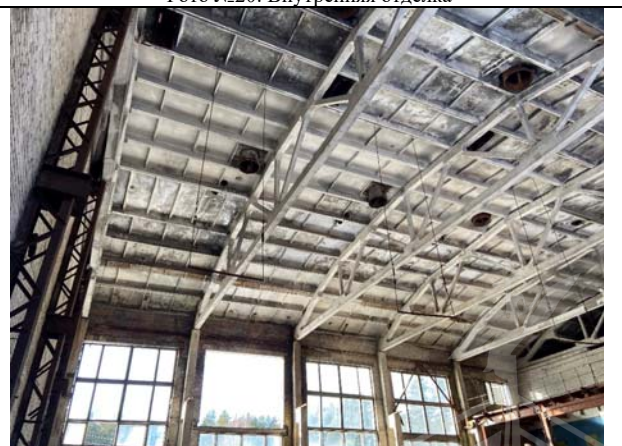
Фото №22: Внутренняя отделка
