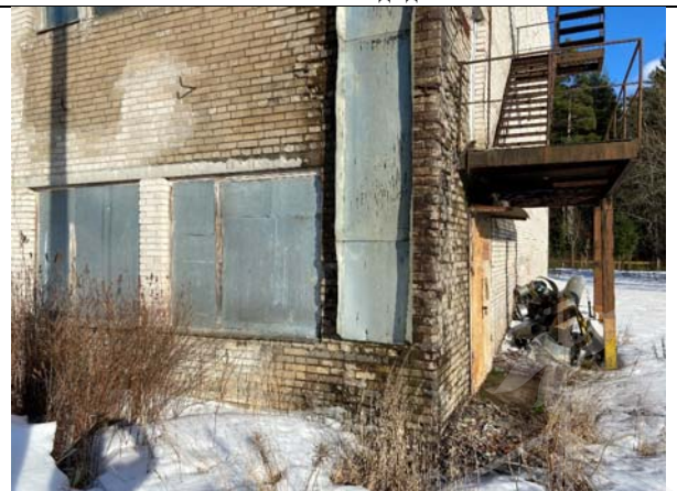
Фото №14: Фасад здания
