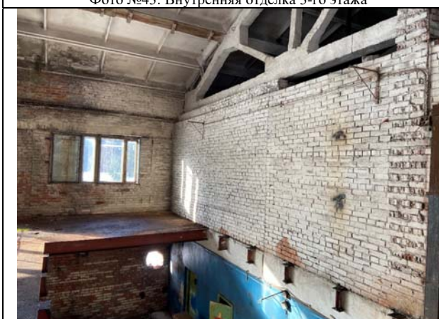
Фото №45: Внутренняя отделка 3-го этажа
