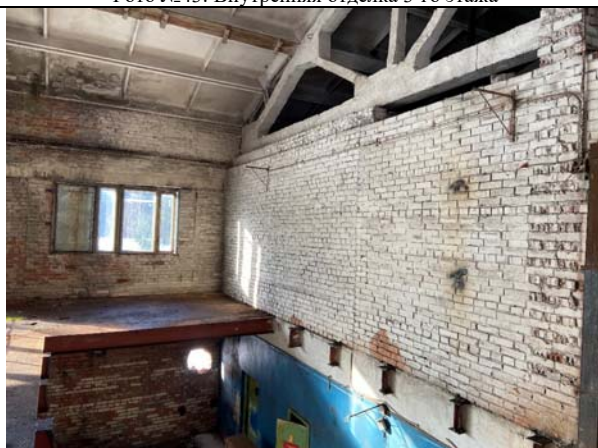
Фото №45: Внутренняя отделка 3-го этажа
