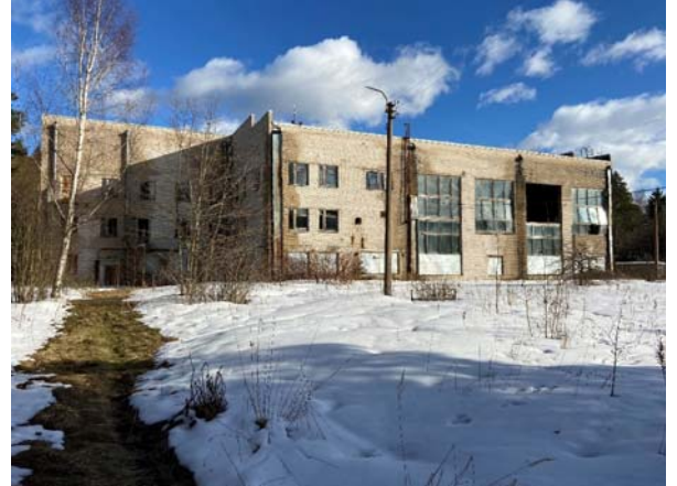
Фото №10: Фасад здания
