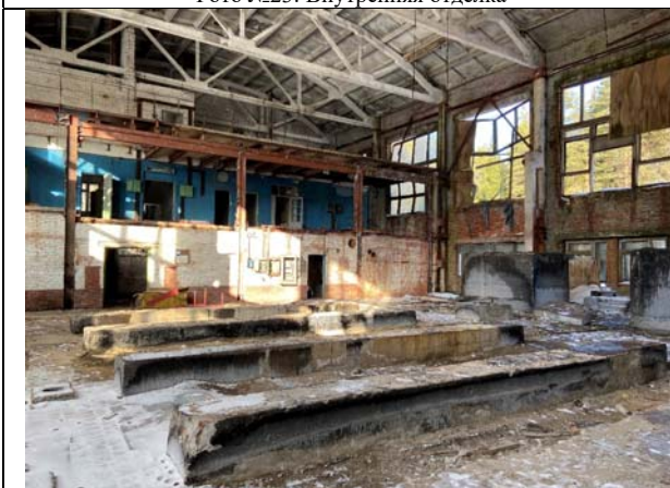
Фото №25: Внутренняя отделка
