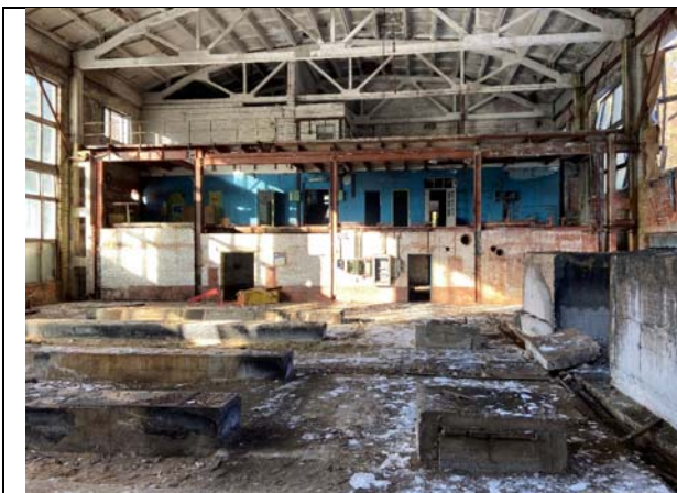
Фото №23: Внутренняя отделка
