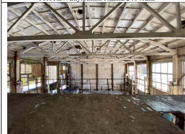
Фото №41: Внутренняя отделка 3-го этажа
