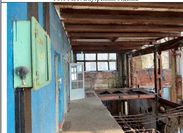
Фото №35: Внутренняя отделка 2-го этажа
