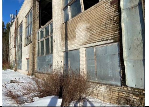
Фото №16: Фасад здания
