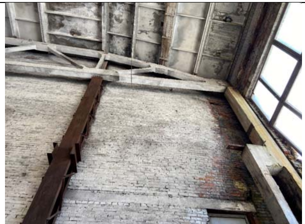
Фото №24: Внутренняя отделка
