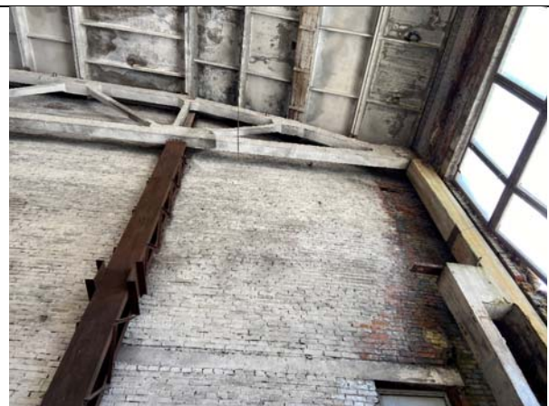
Фото №24: Внутренняя отделка
