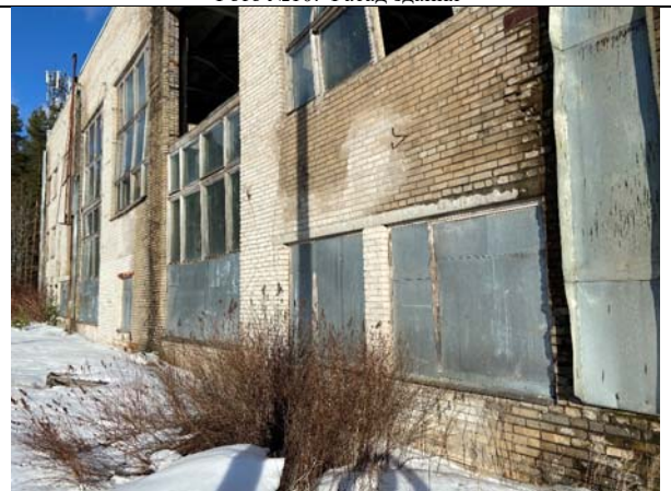
Фото №12: Фасад здания
