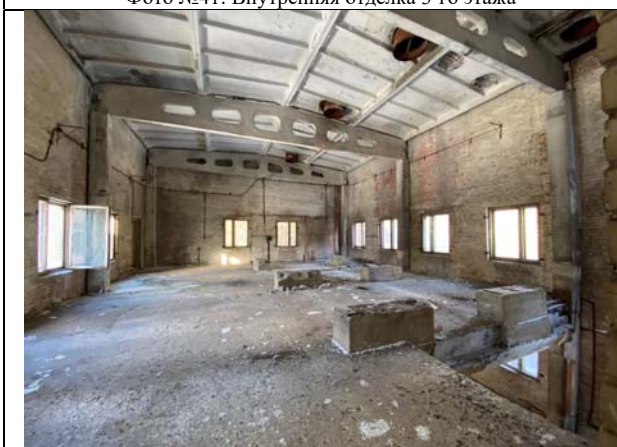
Фото №43: Внутренняя отделка 3-го этажа
