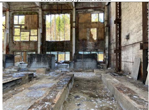
Фото №26: Внутренняя отделка
