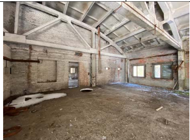
Фото №42: Внутренняя отделка 3-го этажа
