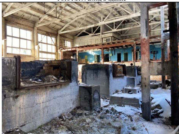
Фото №21: Внутренняя отделка
