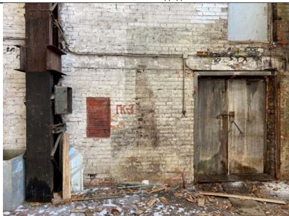
Фото №19: Вход в здание
