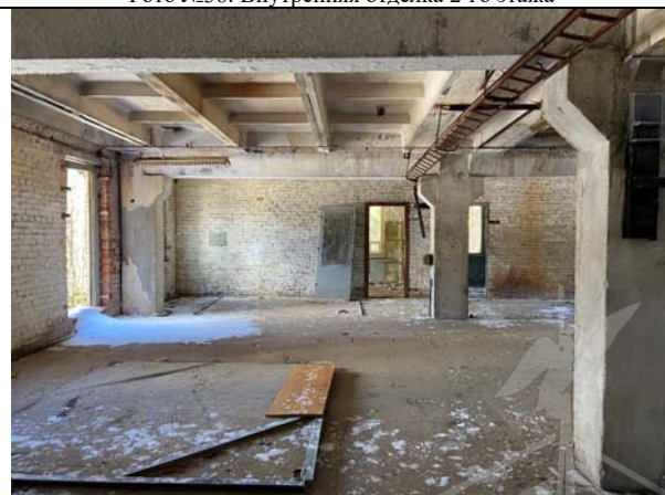
Фото №38: Внутренняя отделка 2-го этажа
