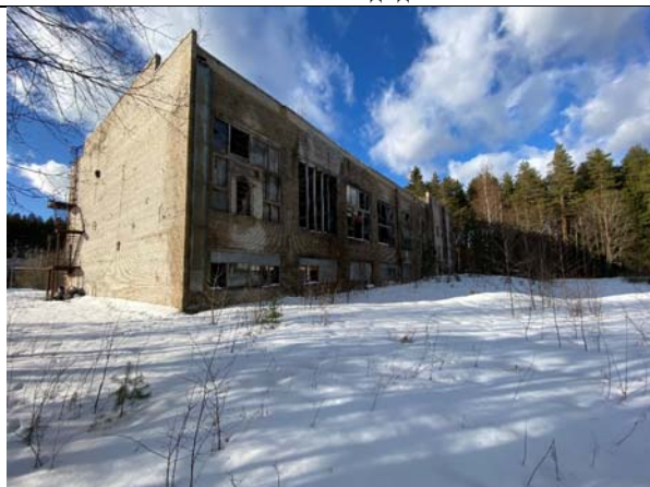
Фото №13: Фасад здания
