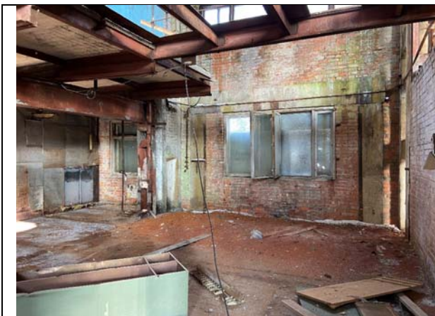
Фото №31: Внутренняя отделка
