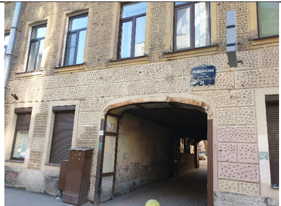
Фото № 19. Внешнее окружение. Вход во двор
