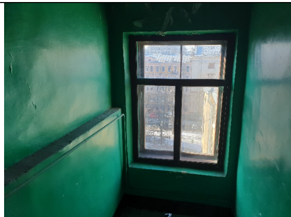
Фото № 2. Лестничная клетка
