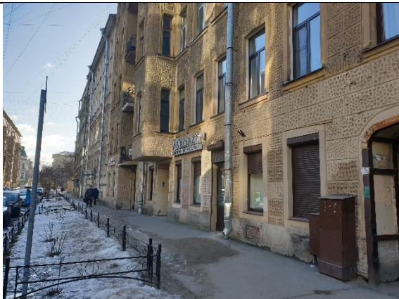
Фото № 18. Внешнее окружение вид с улицы
