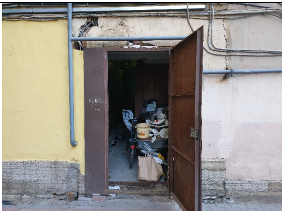
Фото № 1. Общий вход
