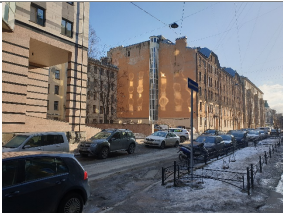
Фото № 20. Внешнее окружение вид с улицы
