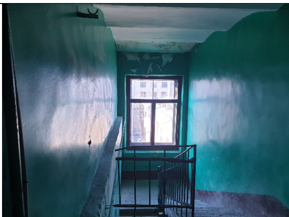
Фото № 3. Лестничная клетка
