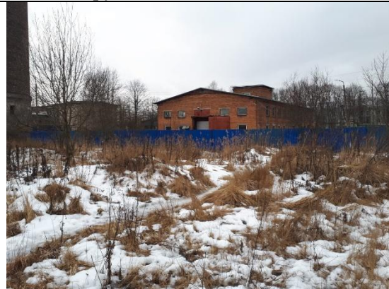
Фото 14. Вид территории и ближайшее окружение Объекта оценки
