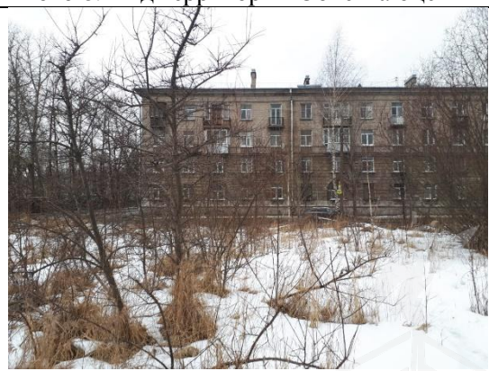
Фото 10. Вид территории и ближайшее окружение Объекта оценки
