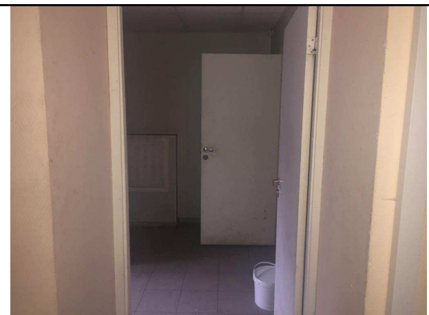
Фото 50. Типичное состояние Объекта оценки
