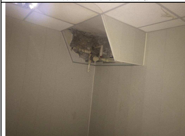
Фото 53. Типичное состояние Объекта оценки
