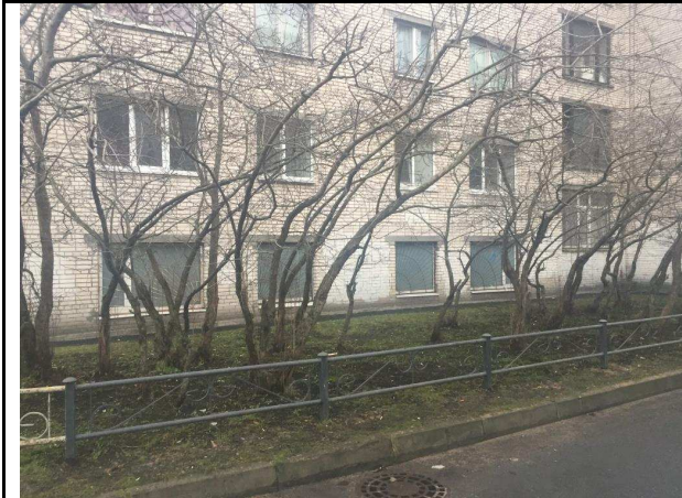
Фото 19. Вид на окна Объекта оценки
