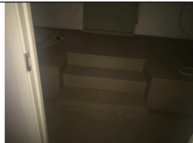
Фото 36. Типичное состояние Объекта оценки
