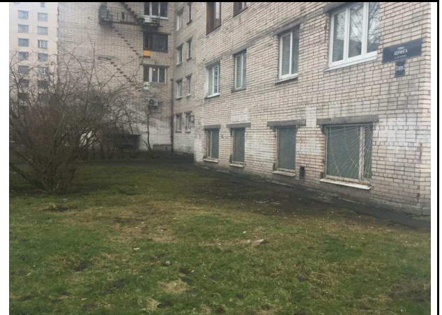
Фото 20. Вид на окна Объекта оценки
