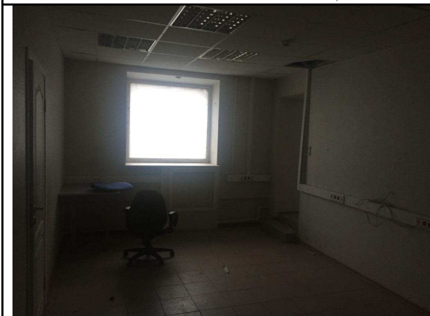
Фото 27. Типичное состояние Объекта оценки
