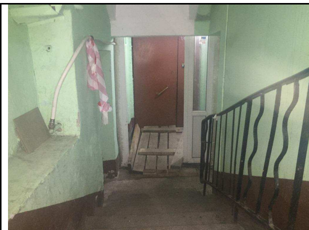
Фото 41. Лестница здания Объекта оценки
