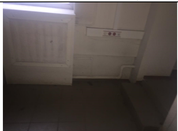
Фото 28. Типичное состояние Объекта оценки
