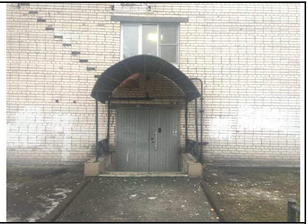
Фото 18. Вход в Объект оценки
