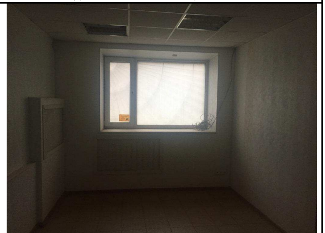
Фото 22. Типичное состояние Объекта оценки
