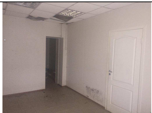
Фото 26. Типичное состояние Объекта оценки
