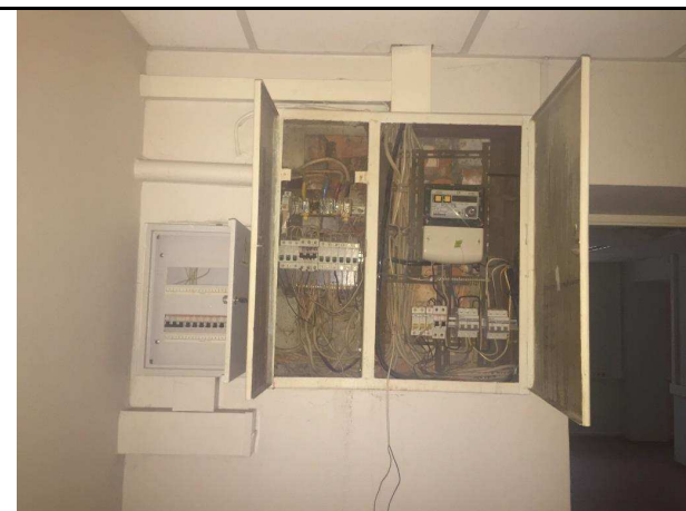
Фото 34. Типичное состояние Объекта оценки
