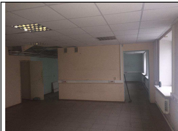
Фото 49. Типичное состояние Объекта оценки
