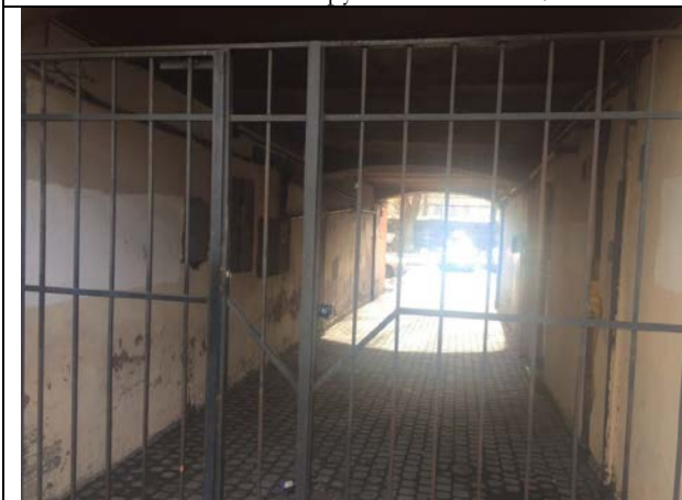
Фото 11. Проход через арку к Объекту оценки
