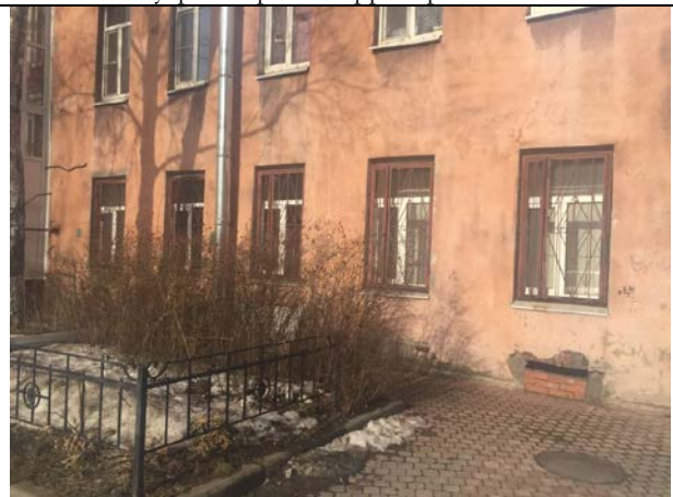
Фото 16. Внутри дворовая территория Объекта оценки
