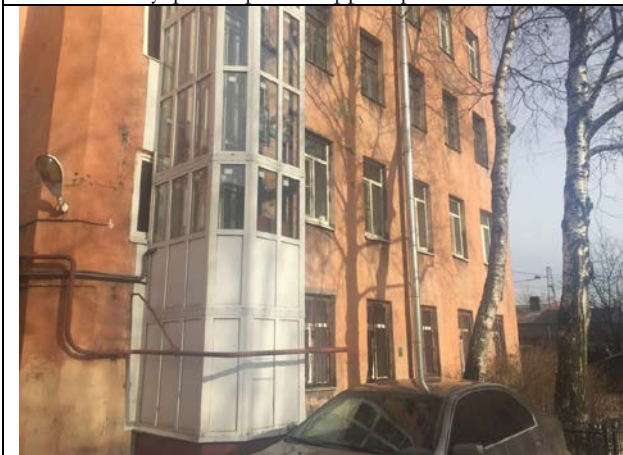
Фото 15. Внутри дворовая территория Объекта оценки
