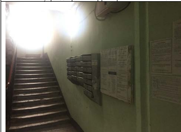
Фото 17. Вид парадной здания расположения Объекта оценки
