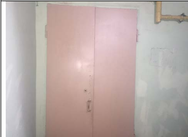
Фото 19. Входная дверь (парадная жилого дома) Объекта оценки
