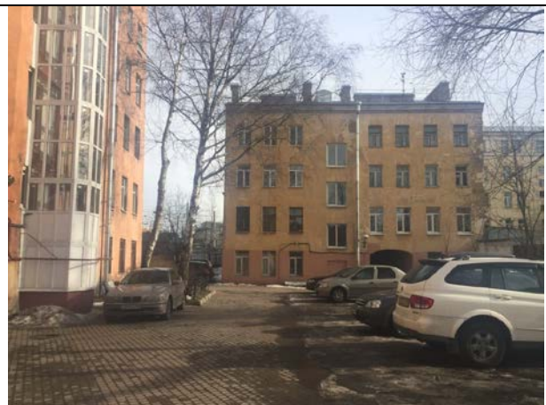
Фото 14. Внутри дворовая территория Объекта оценки
