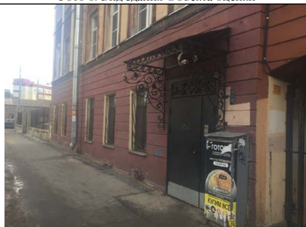
Фото 10. Общий вход с улицы Объекта оценки
