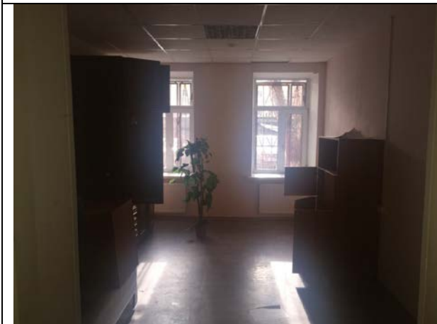
Фото 23. Типичное состояние Объекта оценки
