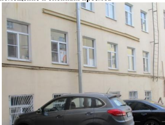
Фото 8. Оконные проемы, во двор
