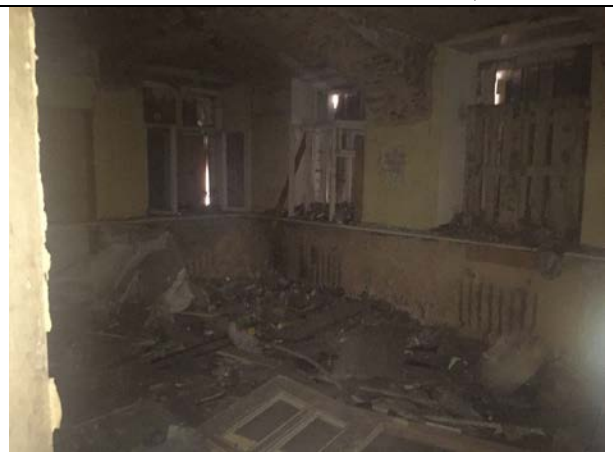
Фото 40. Типичное состояние Объекта оценки
