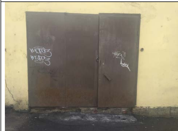
Фото 23. Вход в оцениваемое здание
