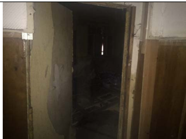
Фото 36. Типичное состояние Объекта оценки
