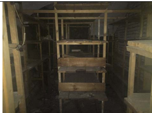
Фото 28. Типичное состояние Объекта оценки
