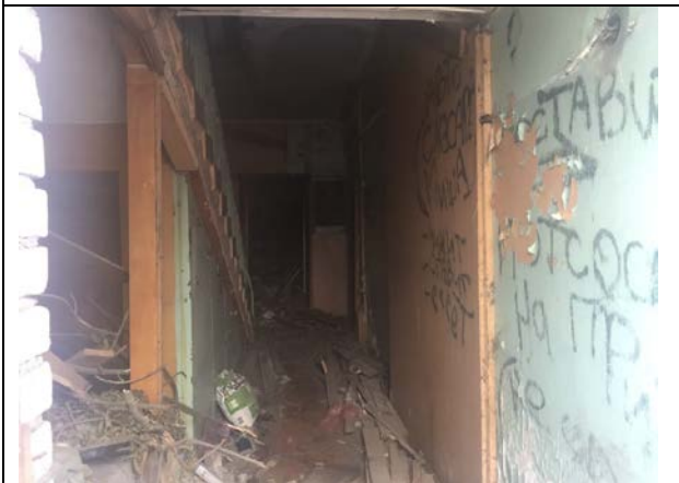
Фото 25. Типичное состояние Объекта оценки
