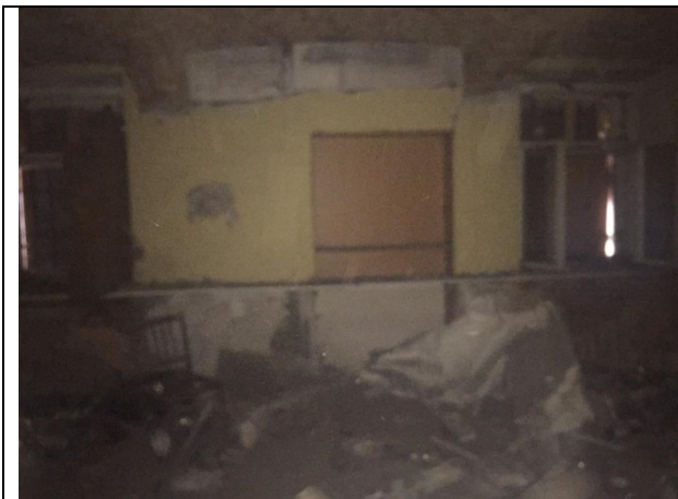
Фото 35. Типичное состояние Объекта оценки
