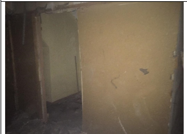
Фото 47. Типичное состояние Объекта оценки
