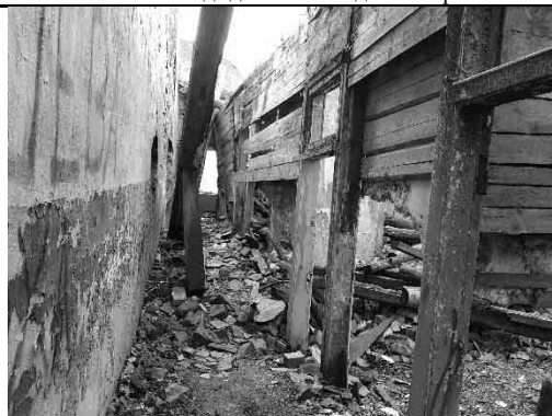
Фото №4: Вид помещений второго этажа здания.
