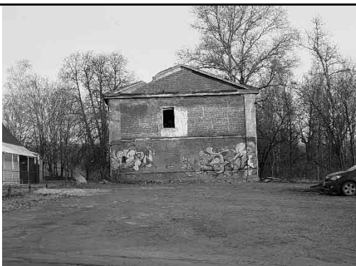
Фото №1: Вид здания с южной стороны.
