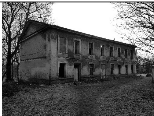
Фото №2: Вид здания с западной стороны.
